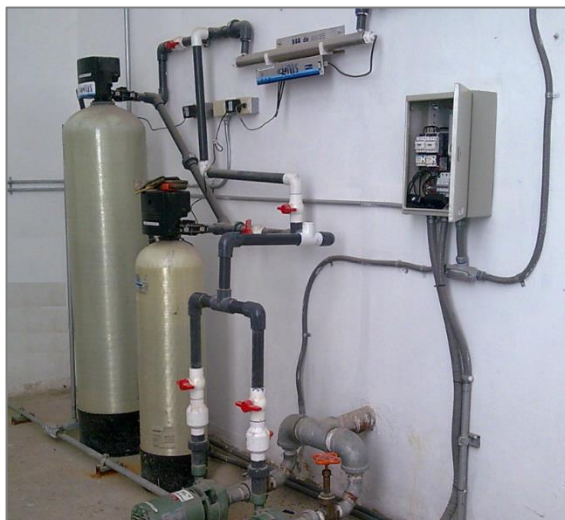
Equipo de Filtrado y Germicida. Para el reúso de agua en muebles sanitarios.
