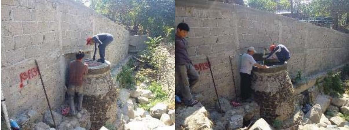
Se observa en las imágenes el pozo de visita 139 que forma parte del primer colector, y se muestra la medida lineal de su profundidad.
