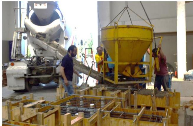
*Figura 3.4: Colado del concreto en los modelos.*
