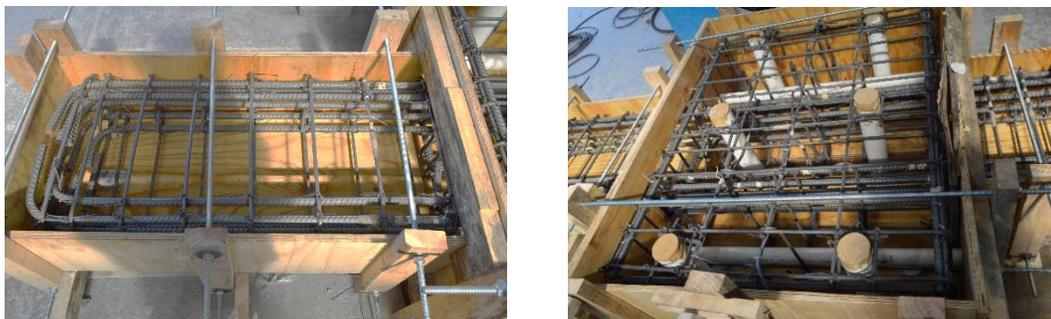
c) Viga lado sur b) Elemento rígido central con ductos.
