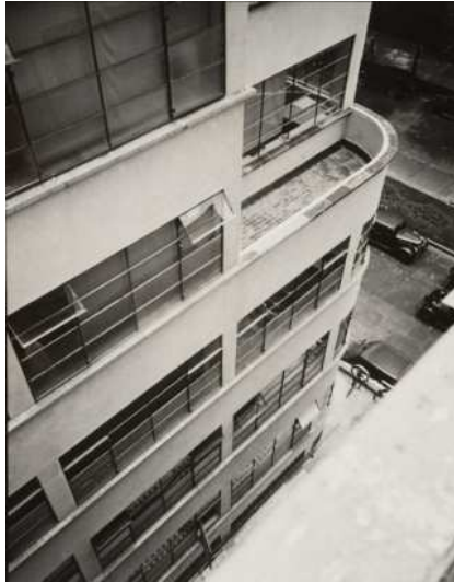
Fig. 35. Esther Born, Edificio de oficinas, 1935-1936. Obra del arquitecto Enrique de la Mora
