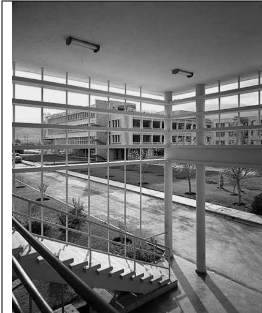
Fig. 119. Arno Brehme, escalera del edificio de Aulas I hacia la parte posterior del edificio de la Biblioteca, 1954
