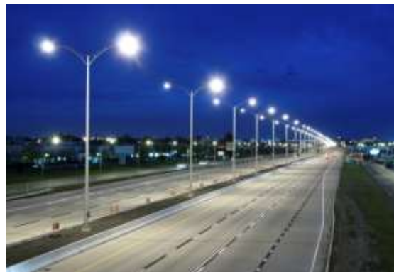
Figura 4.34 Luminarias en el centro del boulevard.
