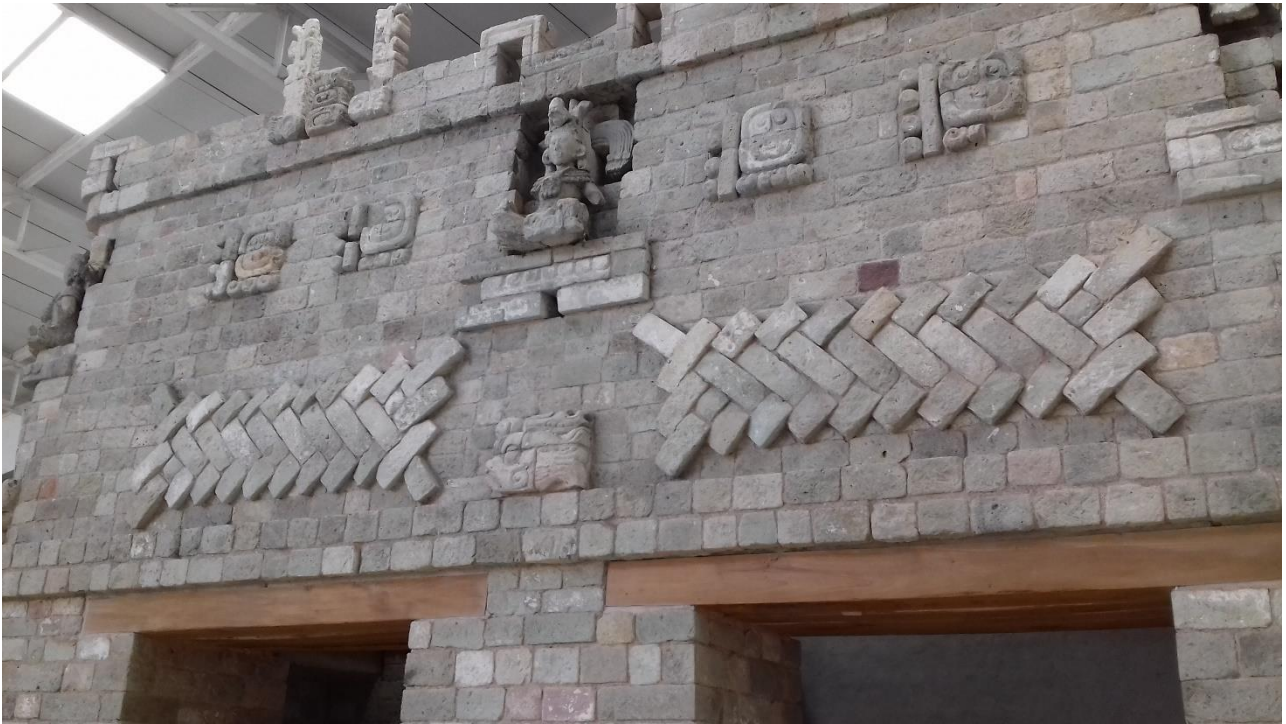
Figura 3-11: Reconstrucción de la Estructura 10L-22A, el llamado Popol Nah; foto tomada por el autor, en el museo de sitio.
