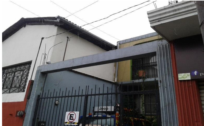
Fotografía 7.-Trabe de la cochera de una casa. Uruapan, Michoacán.
