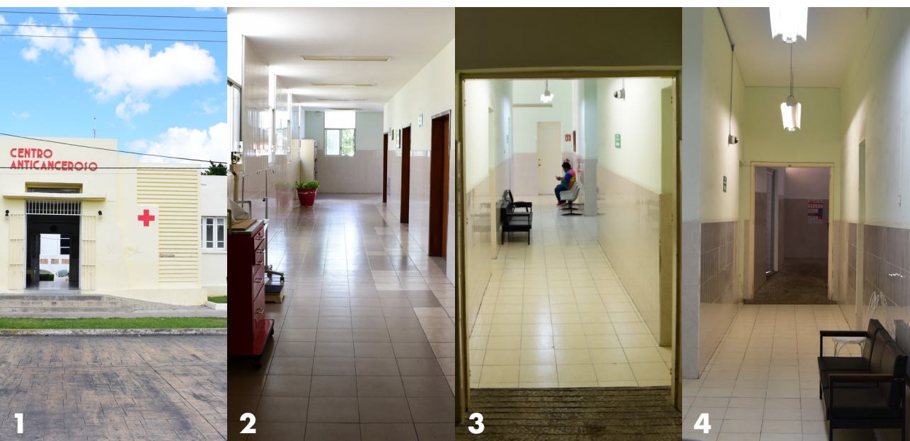
Imagen 70. Fotografías de la autora de 4 diferentes accesos y su accesibilidad a espacios para personas con discapacidad motriz. (1) Rampa en acceso principal, (2) Pasillo en habitaciones del área de hospitalización, (3) Pasillo de espera para radio terapia (4) Rampa de acceso a hospitalización.
