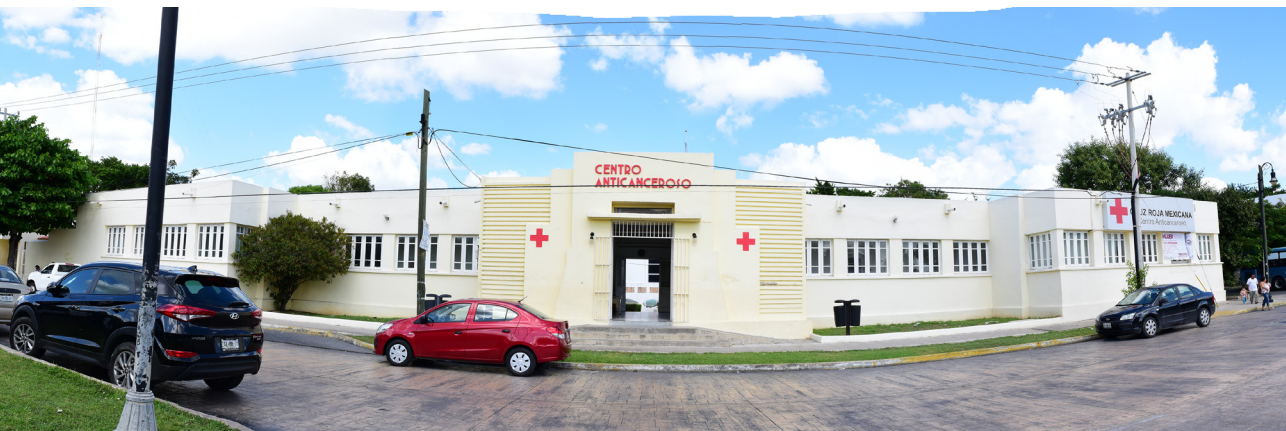
Imagen 34. Fotografía archivo propio de la autora. Fachada principal del caso de estudio.
