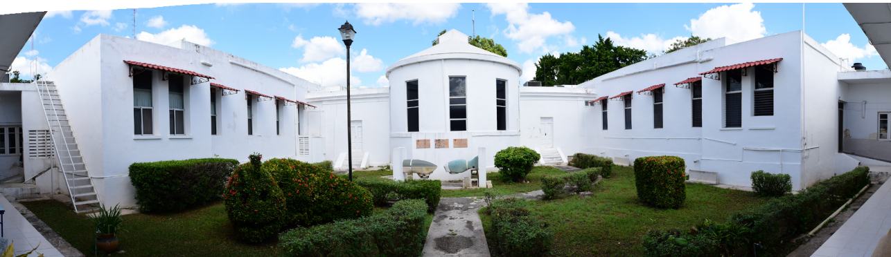
Imagen 36. Fotografía archivo propio de la autora. Vista al jardín interior del caso de estudio
