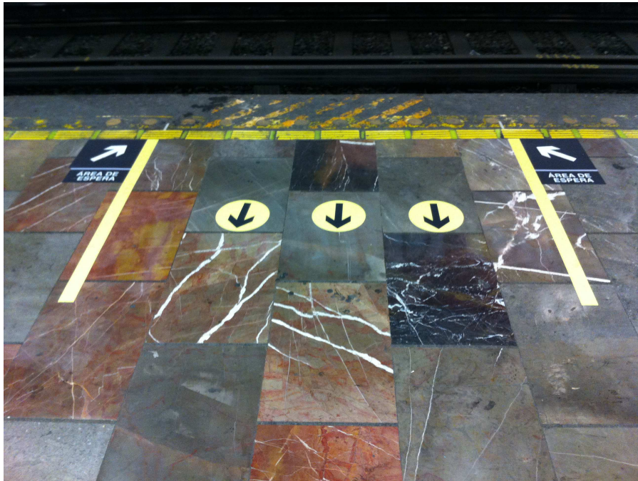
Figura 61: Señalamiento instalado en plataforma.
