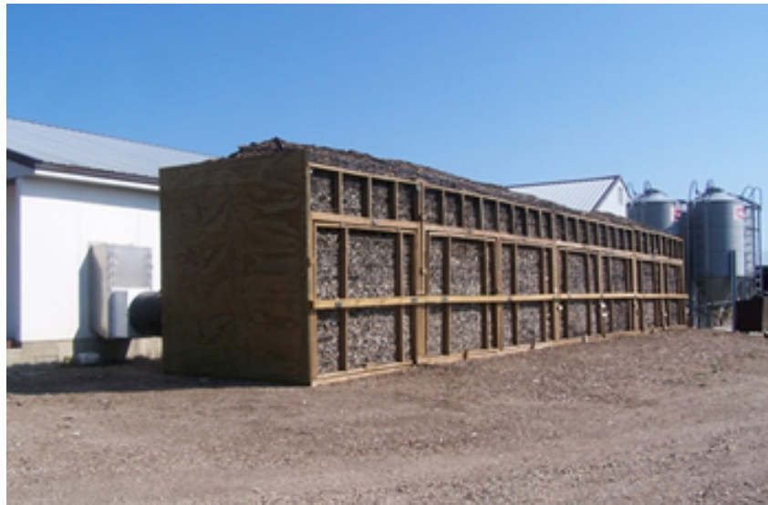
Figura 6. Biofiltro abierto de múltiples lechos, en configuración vertical. (Harmor, Hoff, & Rieck-Hinz, 2014)
