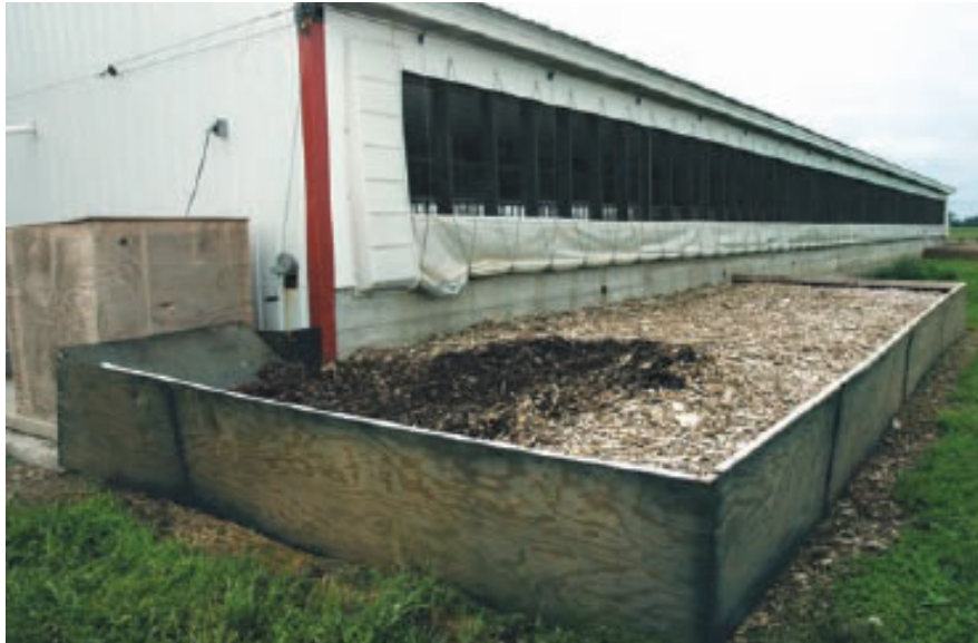
Figura 7. Biofiltro de lecho abierto, con reactor de madera. (Harmor, Hoff, & Rieck-Hinz, 2014)
