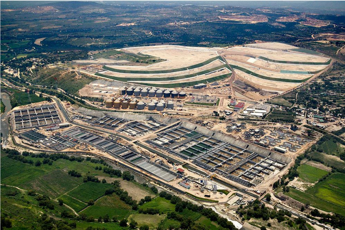
Figura 7. Planta de Tratamiento de Aguas Residuales Atotonilco (PTAR). Fuente: ULMA (2011).
