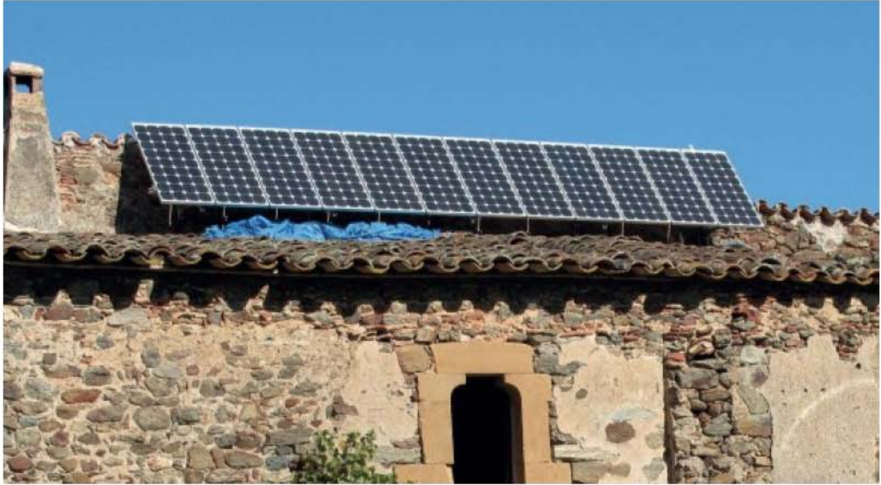
Ilustración 4. Ejemplo de clasificación BAPV Imagen tomada del sitio: http://energia-rural.com/wp-content/uploads/Electricidad-para-casa-rural-1024x383.jpg?d8dfb8
