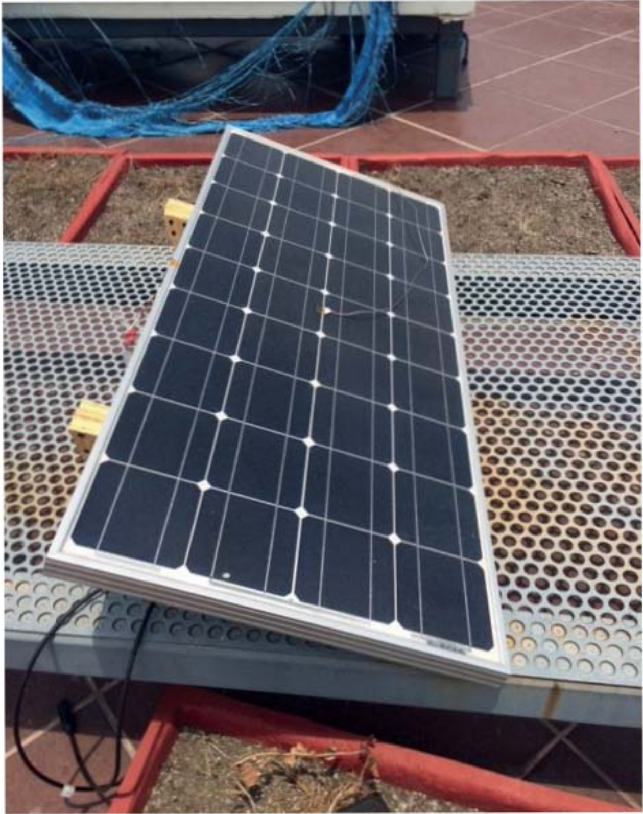
Ilustración 9. Medición de temperatura de un panel fotovoltaico de silicio monocristalino en la Unidad de Posgrado, UNAM
