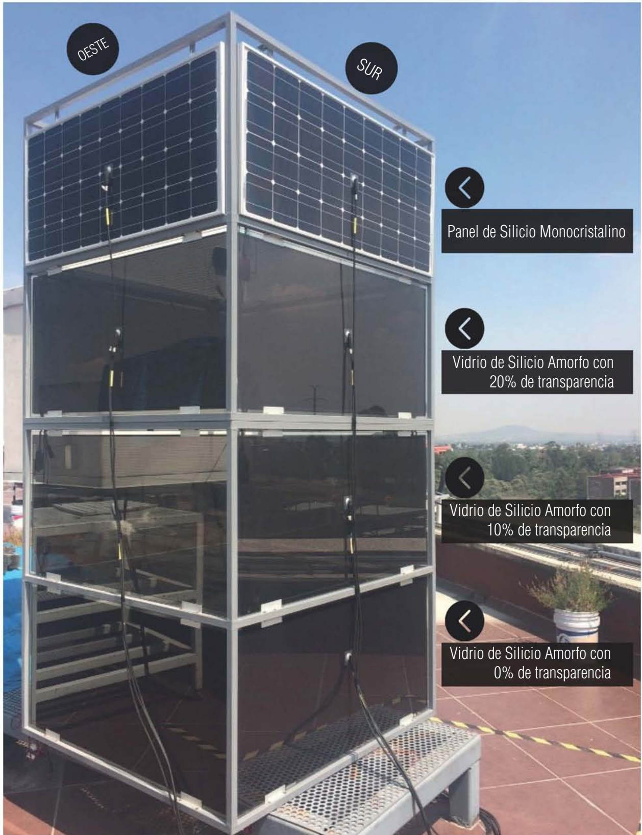
Ilustración 19. Instalación paneles fotovoltaicos.
