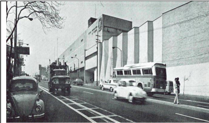
[Fotografía de la Fachada de la Prepa 4]. Recuperada de https://www.facebook.com/prepa4/photos/a.179111752105027.47949.141356242547245/513507235332142/?type=3&theater
