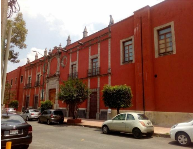
Hernández, B. (2017). Fachada del Ex Arzobispado [Fotografía]
