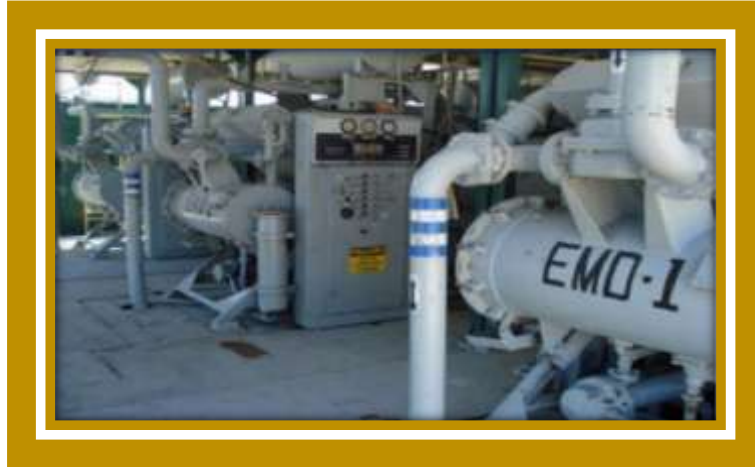
Figura 1.17. Motores de generación de energía tipo diésel. Tomada de notas de clase “Elementos De Perforación”. Mario Rosas.
