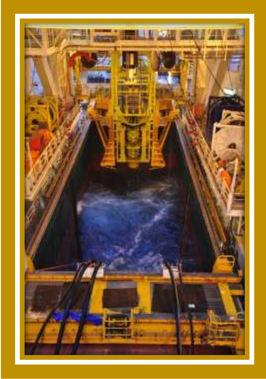
Figura 6.11. BOP utilizado dentro de las plataformas como barrera secundaria de seguridad en contra de la entrada de fluidos provenientes de la formación.
