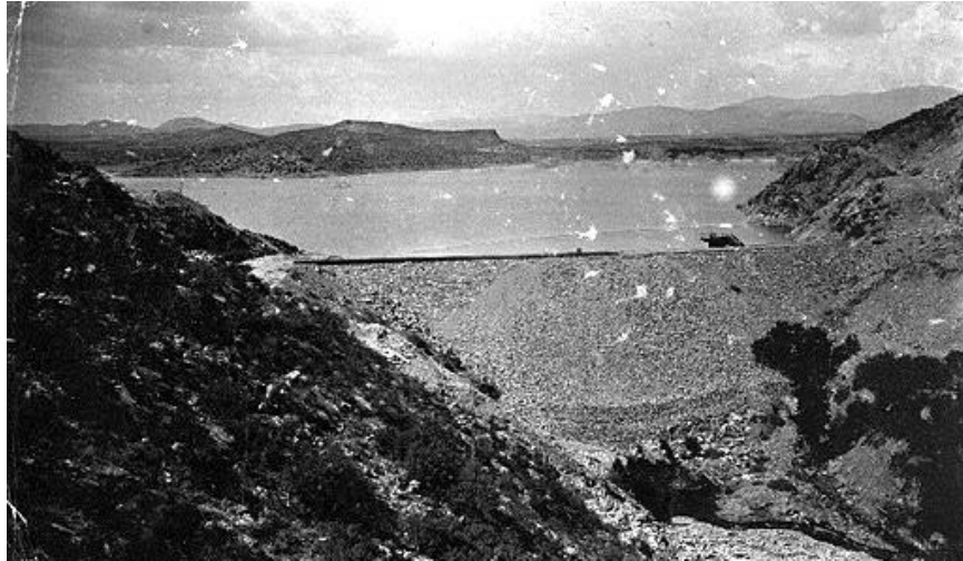
Ilustración 2.4 Presa Walnut Grove. USA,(de roca suelta). Falla por fuertes nevadas y lluvias en 1980
