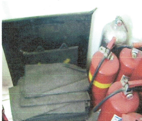
Foto 39. Tanques de oxígeno inservibles extintores
