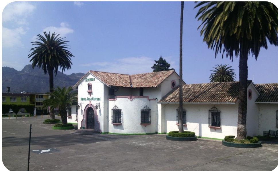
Vista actual de la Escuela Primaria "Manuel Ávila Castillo"
