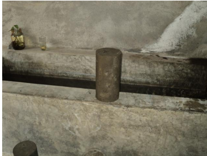
Foto 3.8. Pila para el curado de cilindros de concreto
