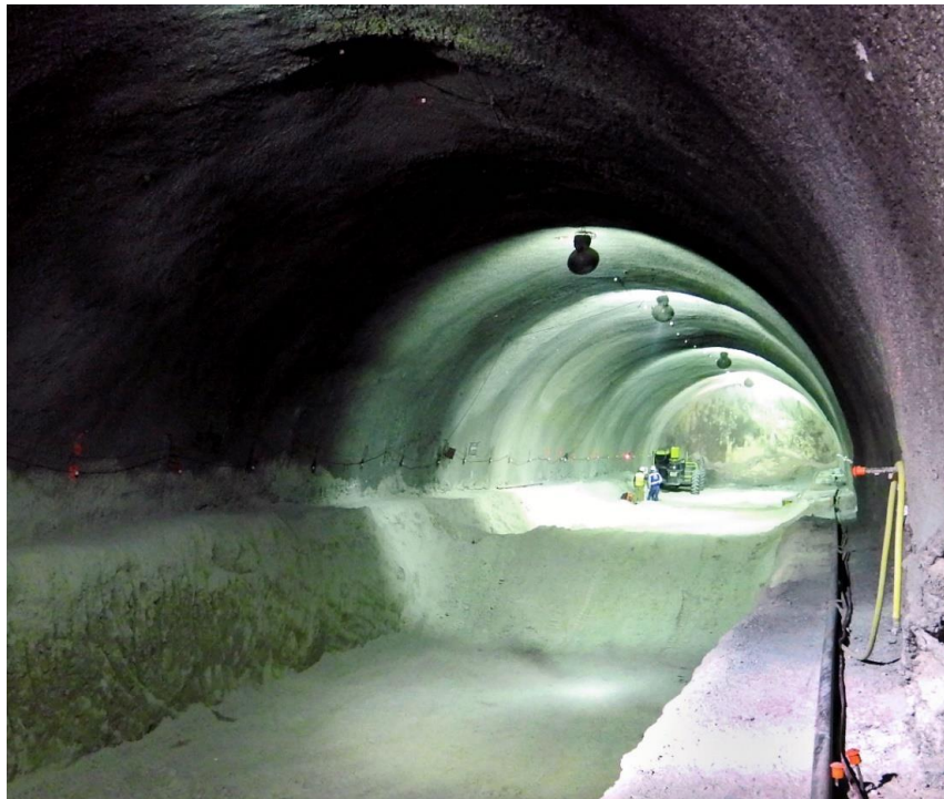
Figura 155. Fotografía del avance de la media sección superior y el banqueo central.
