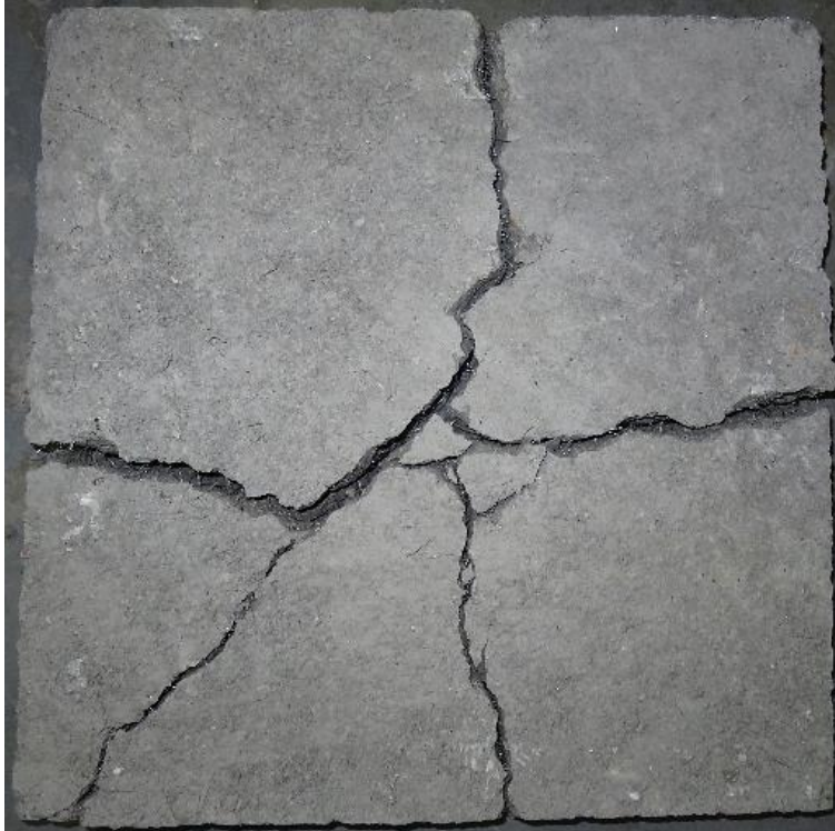
Figura 65. Falla de un panel en una prueba real de laboratorio visto desde la parte inferior. Cortesía del Laboratorio Consultec-Geosa (2017).
