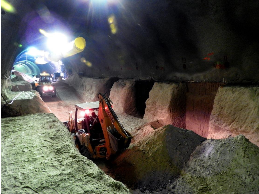
Figura 156. Banqueros laterales por bataches.
