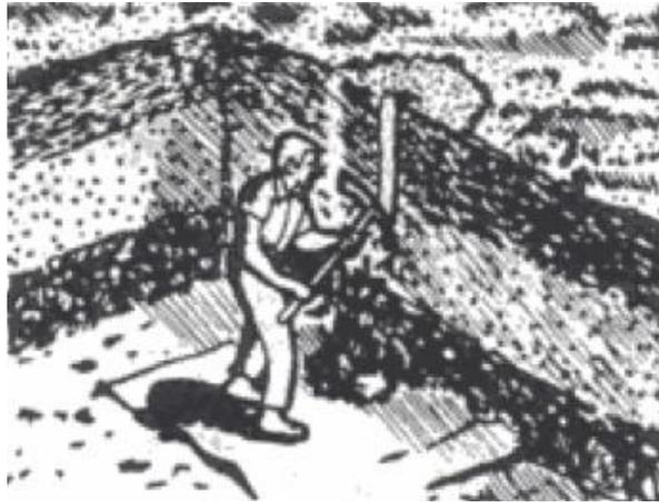
Imagen 1.15. Muestras integrales, en zanjas abiertas o de cortes.
