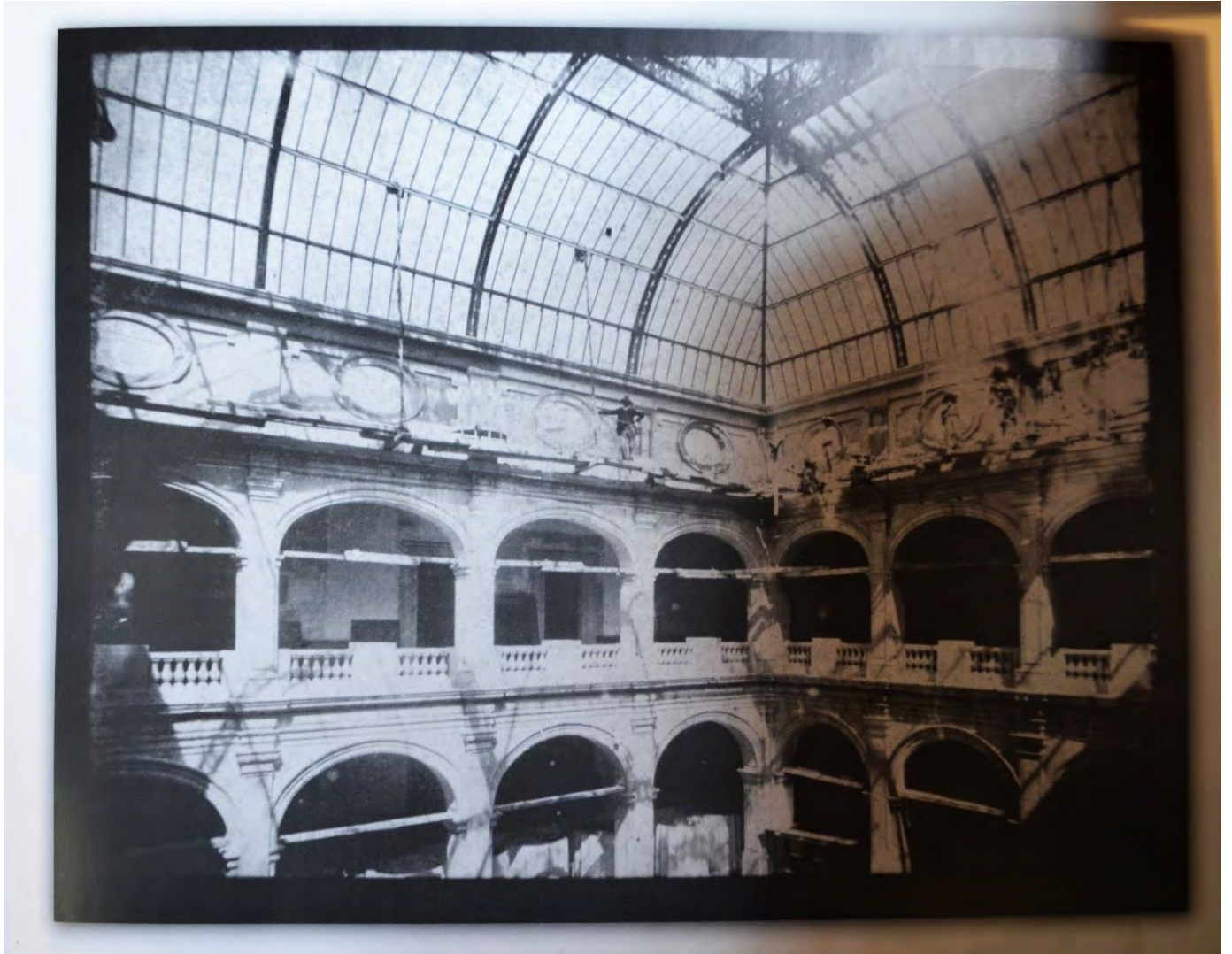
144. AUTOR DESCONOCIDO, Construcción de la cúpula, ca. 1913 17.5x22 cm Colección ENAP/UNAM
