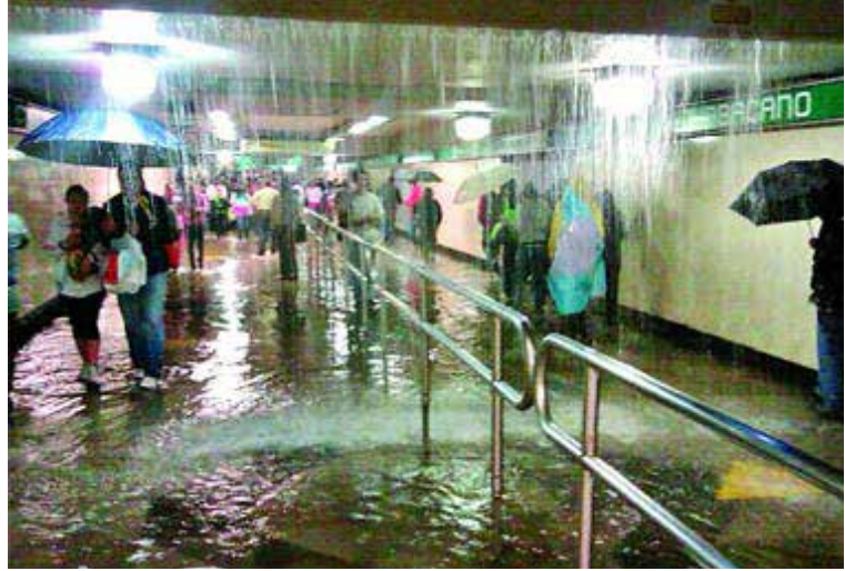
Estación del metro inundada. 2015. Recuperado del 18 de marzo de 2017, de http://www.atraccion360.com/plan-para-desaparecer-filtraciones-de-agua-en-el-metro-de-la-cdmx
