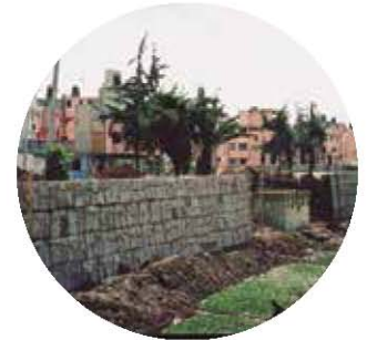
Canal Nacional durante la intervención.
