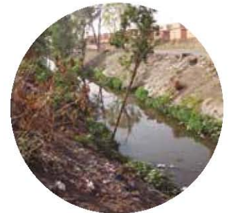
Canal Nacional antes de la intervención.
