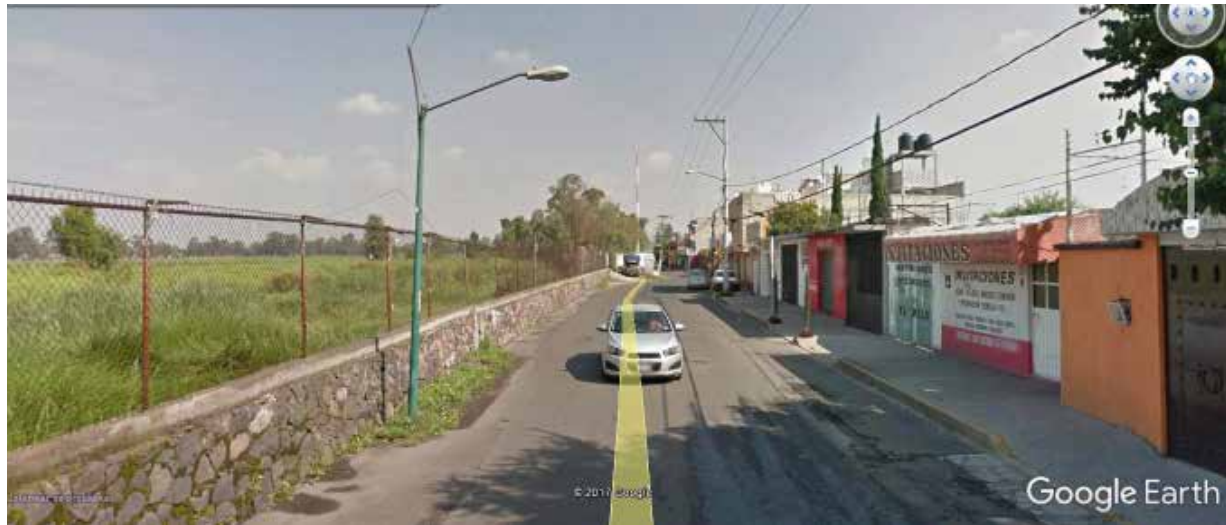
Estado actual de la calle Canal de Chalco, colindando al nororiente de la Ciénega Grande.
