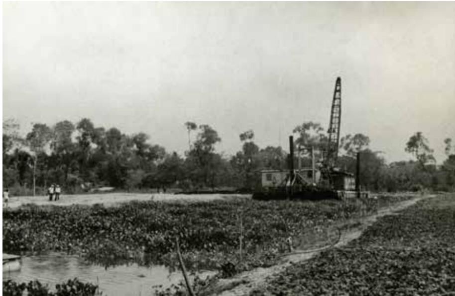
Construcción de camellones chontales con draga en Nacajuca. Recuperado el 17 de diciembre de 2016, de http://2.bp.blogspot.com/
