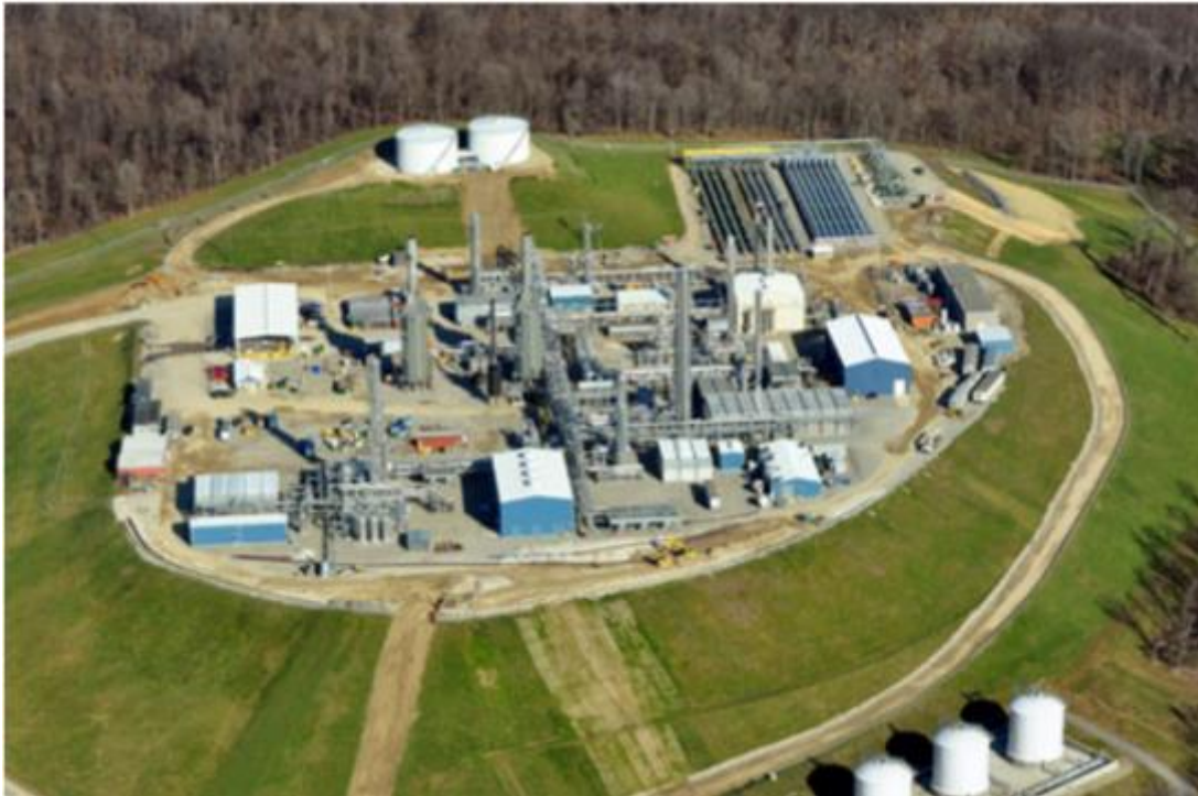
Figura 3.12.- Instalación de procesamiento de shale en la región Marcellus, Pennsylvania.
