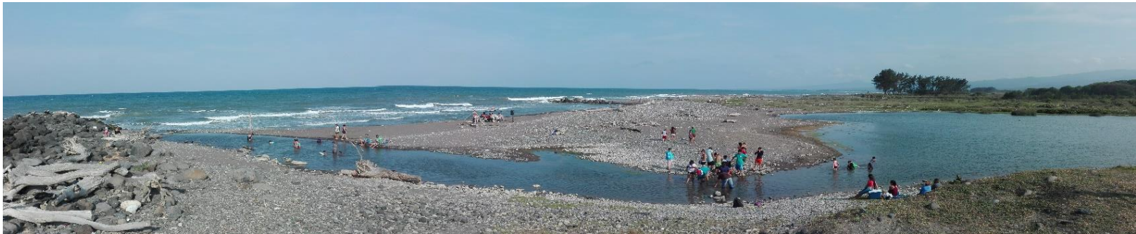
Figura 8.1: Zona con alto grado de erosión de la Playa de lechuguillas: Fuente: Fotografías tomadas en el sitio.
