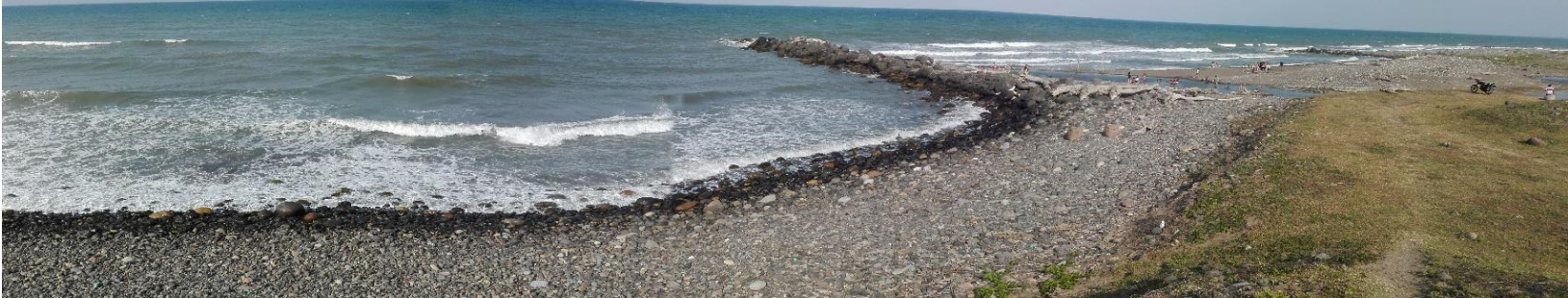
Figura 8.0: Zona de espigón de la Playa de Lechuguillas. Fuente: Fotografías tomadas en el sitio.
