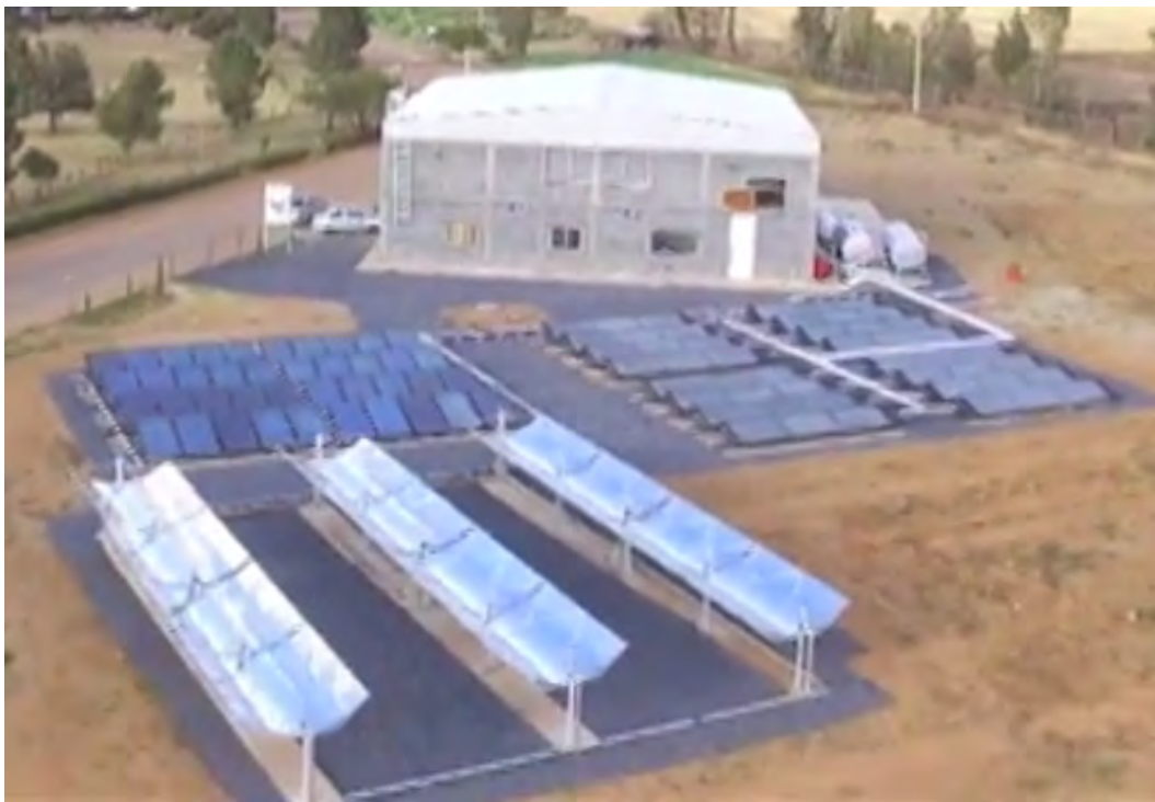
Figura 59. Planta solar de deshidratado de chile en Zacatecas
