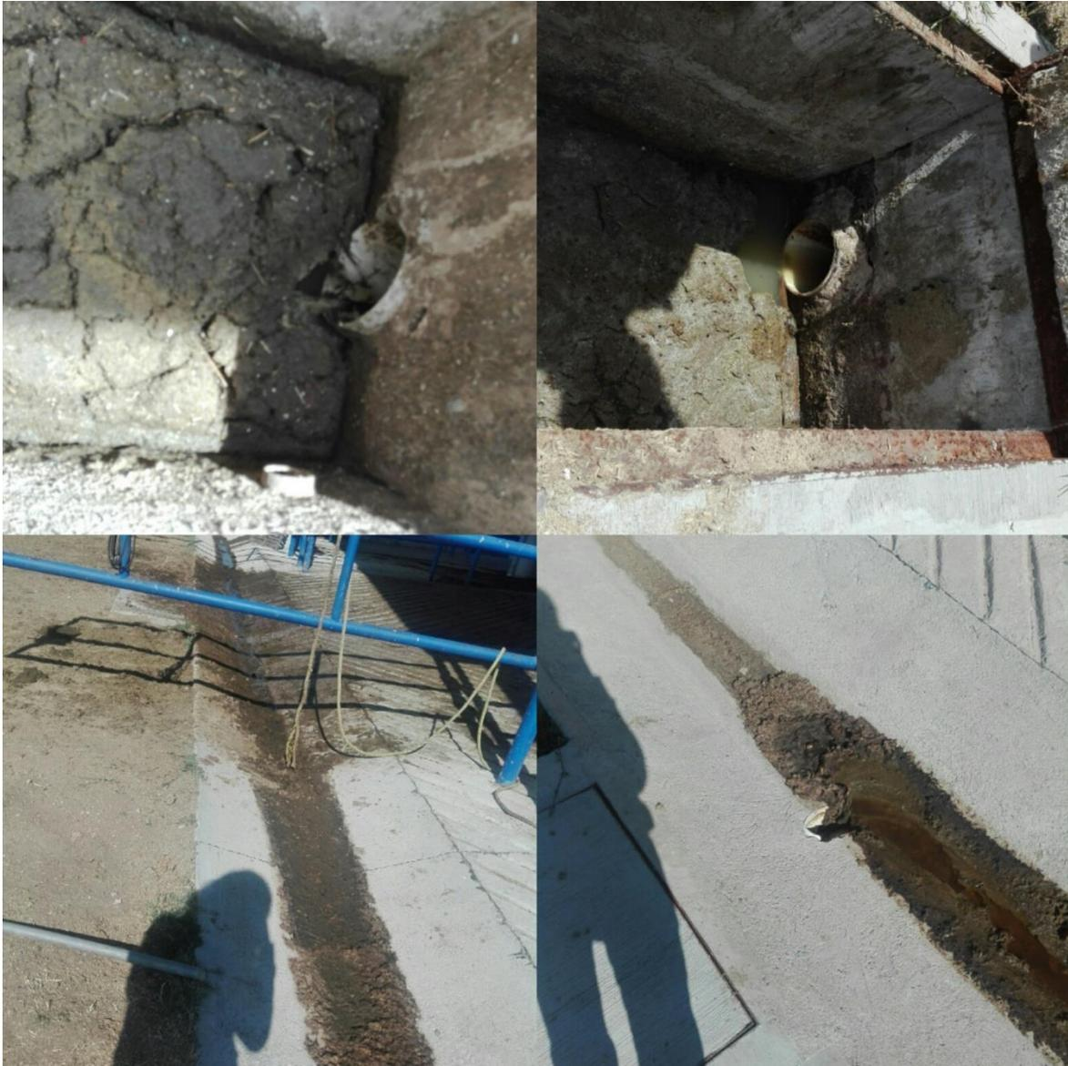
*Figura 3.8. Registros y canal con agua residual estancada*
