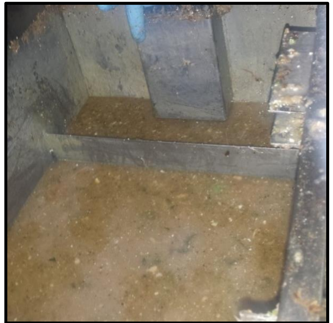
Figura 4.6 Fotografía en donde se observa la retención de compuesto orgánico por sistema de sedimentación [Arellano y Sánchez, 2017]
