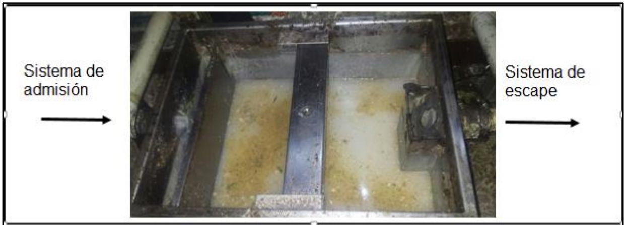
Figura 4.5 Fotografía del sistema de admisión y escape de una trampa de comida japonesa [Arellano y Sánchez, 2017]
