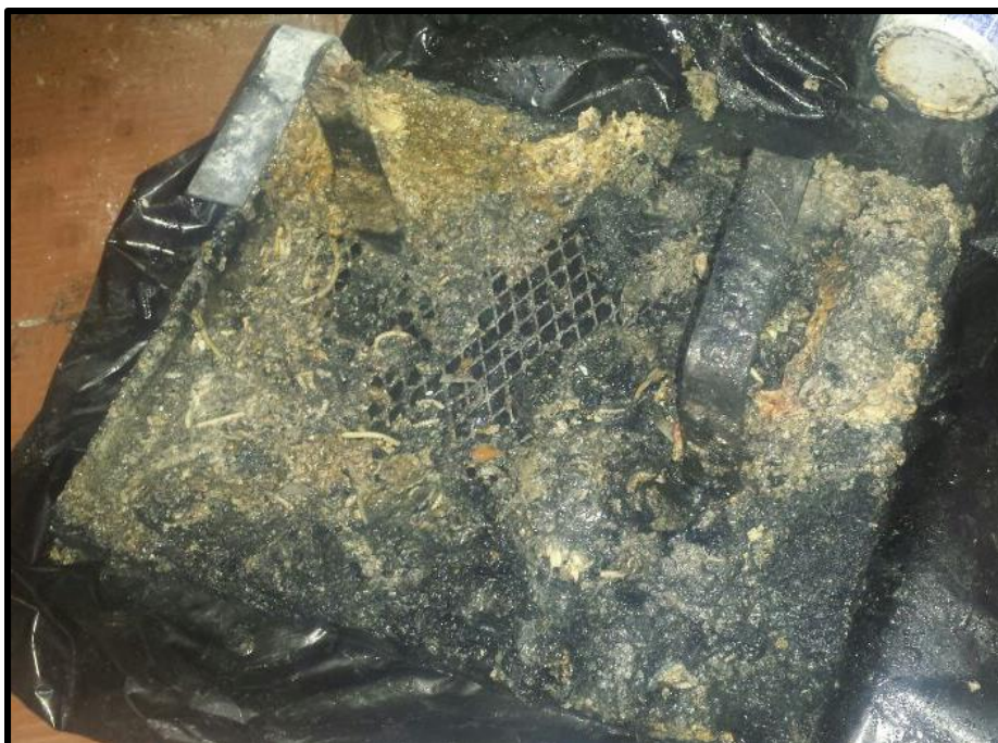
Figura 4.11 Fotografía de la acumulación de moho y comida orgánica en la canastilla que pertenece al sistema de sedimentación [Arellano y Sánchez, 2017]
