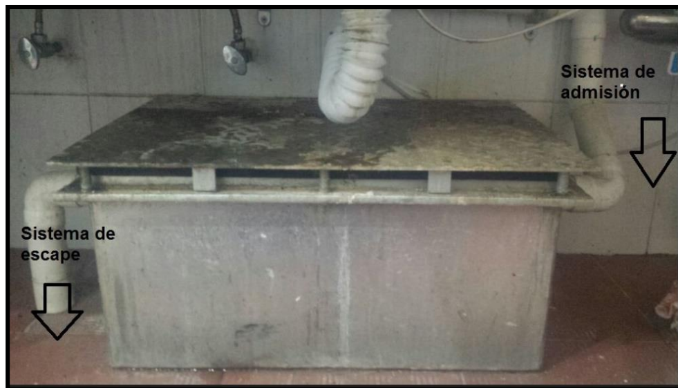
Figura 4.10 Fotografía del sistema de admisión y escape de una trampa de comida libanesa [Arellano y Sánchez, 2017].
