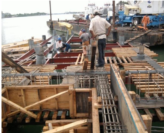
Imagen No.112.- Cimbra con canalones de madera y armados de acero de refuerzo de pilotes, cabezales y traves, de ejes 6, 5, y 4 entre ejes D a G.
