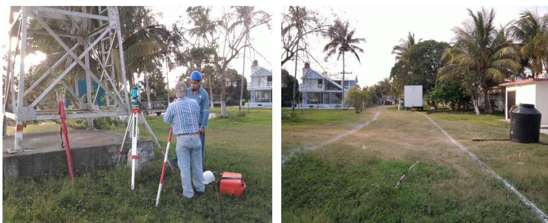
Imagen No.34.- Trazos y niveles para el mejoramiento del camino de acceso al muelle.
