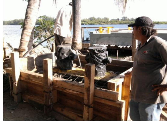
Imagen No.143.- Cimbra común de madera, acero de refuerzo, y colocación de bitas dobles de amarre del buque en tierra.
