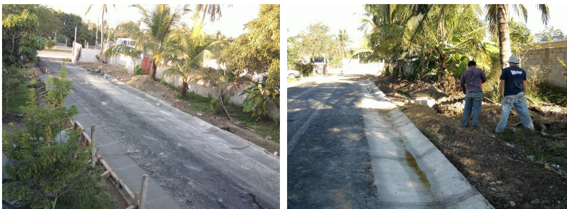
Imagen No.188.- Trazos y niveles de las cepas para las canalizaciones eléctricas, para la acometida de la subestación eléctrica al muelle.
