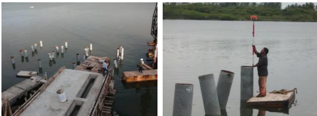
Imagen No.97.- Hincado de pilotes en los ejes 11 y 7 entre los ejes D a G.
