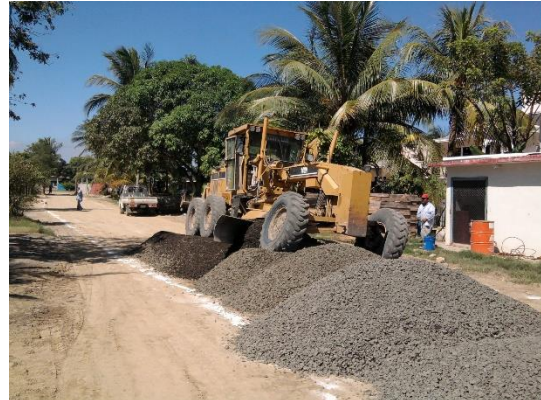
Imagen No.169.-Extendido y Mezclado del material con la Motoconformadora para la sub-base del camino de acceso al muelle.
