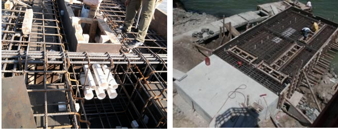
Imagen No.80.- Construcción de trincheras para paso de las instalaciones a base de tuberías de PVC y ángulo estructural, en la construcción de la pasarela de acceso al muelle en río.
