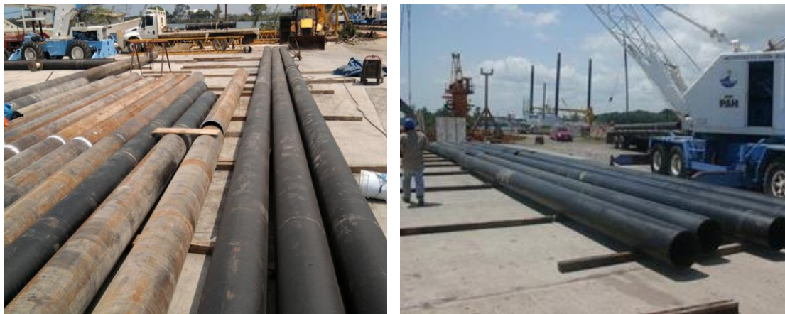
Imagen No.39.- Suministro, Habilitado de Pilotes en Patio del taller y Bodega del Contratista
