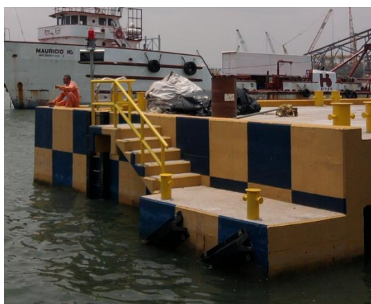
Imagen No.148.- Instalación de diez defensas marinas en muelle del buque y barandal con dos defensas en muelle de lanchas.
