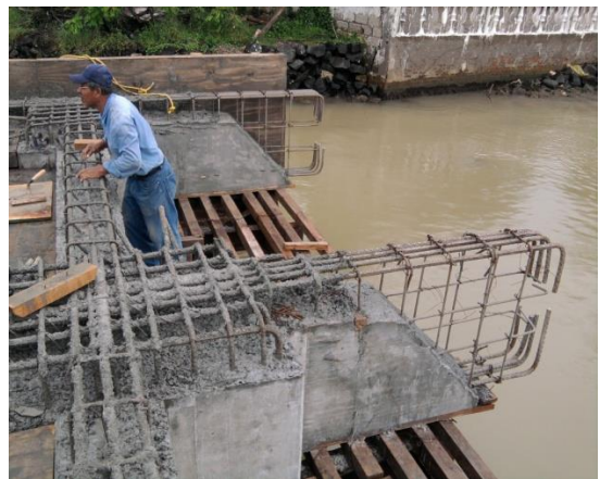
Imagen No.109.- Descimbrado de los tapones en traveses de los ejes 13, 12, 11 y 7 entre ejes D a G, tramos pendientes para continuar con los armados y colar monóticamente con la trabe (T-4) pantalla.
