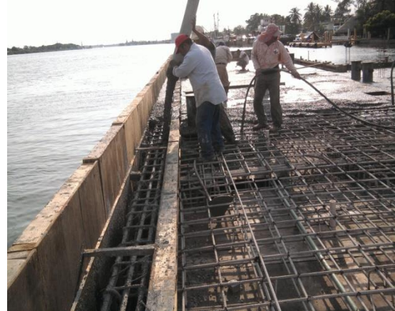
Imagen No.128.- Colocación y acomodo del concreto con los vibradores, extendiendo el concreto con pala, cuchara y regla para dar los niveles y acabado pulido con llana metálica en la trabe T-4, guarniciones y losa del muelle.
