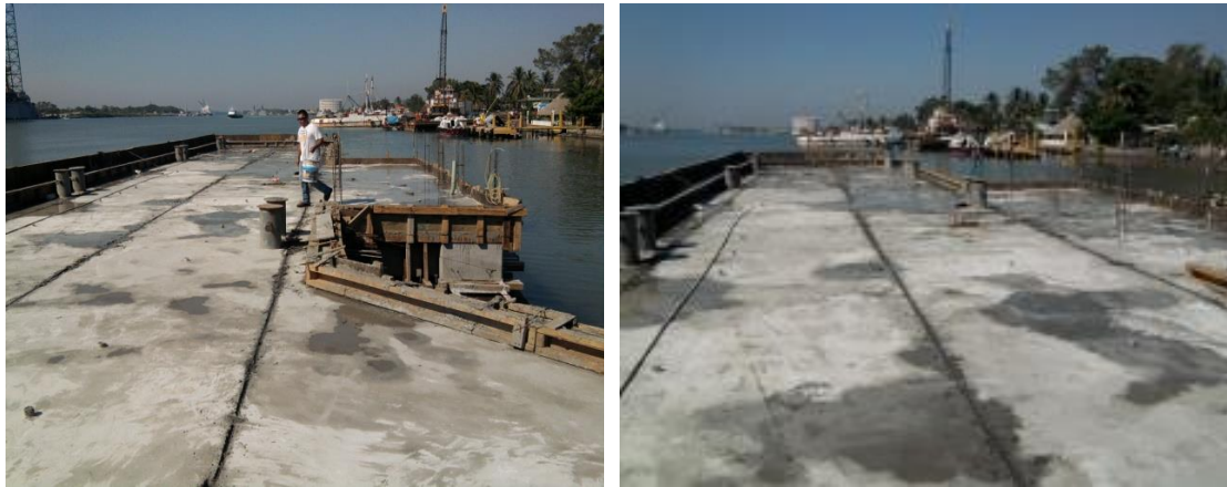
Imagen No.134.- Construcción de juntas en la losa del muelle.
