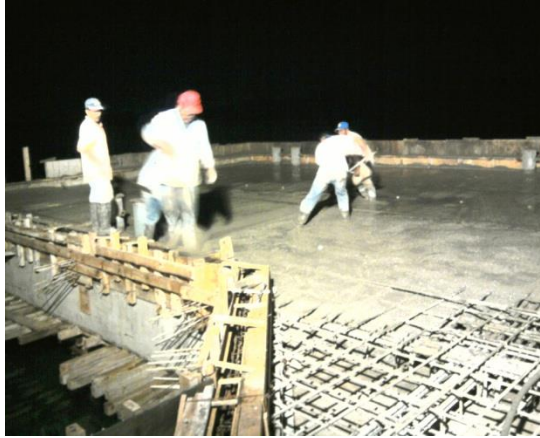
Imagen No.132.- Colado de la trabe T-4 y losa del muelle en el eje G del eje 5 al 13 y del eje 13 desde G a D.
