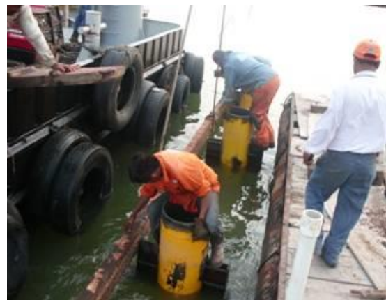
Imagen No.74.- Habilitado, colocación y soldado de ménsulas, para apoyo de la obra falsa de la trabe T-8 en el río.
