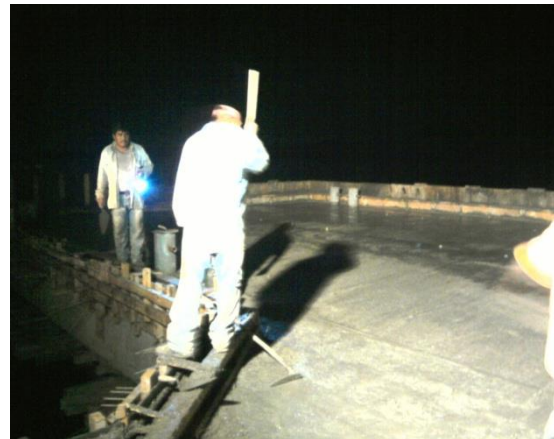
Imagen No.133.- Terminación de los colados de la trabe T-4, guarniciones y losa del muelle, con acabado pulido.
