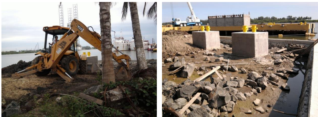
Imagen No.159.-Conformación del muro de contención (tarquina) en tierra, para contener el material producto del dragado del río Tuxpan.
