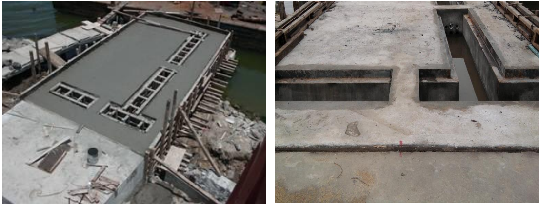
Imágenes No.82.- Colocación de concreto y juntas constructivas, en la pasarela de acceso al muelle en río.
