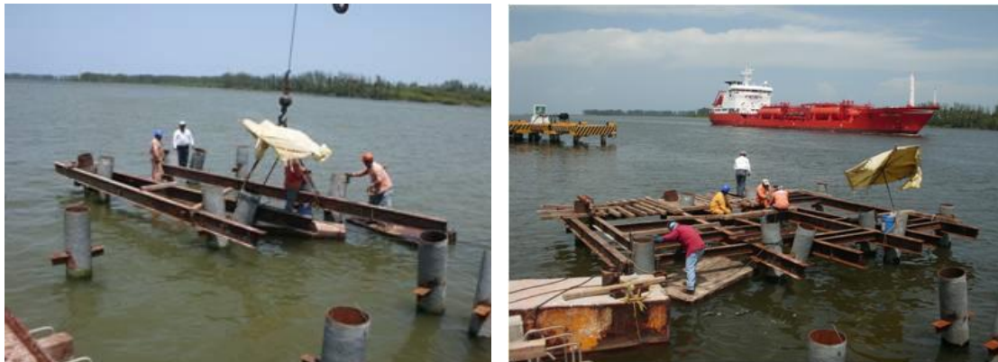
Imagen No.99.- Colocación de la obra falsa, a base de viguetas IPR tipo I de 12"x6.5", para desplante y cimbrado de las trabes, de las superestructuras del muelle.
