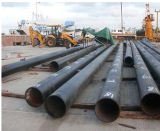
Imagen No.42.- Habilitado y marcado de pilotes para control de los hincados.
