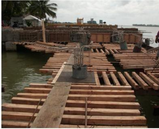
Imagen No.111.- Desplante de cimbra común de madera, habilitados y armados de pilotes, cabezales y traves en ejes 6, 5, y 4 entre los ejes D a G.
