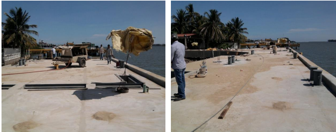
Imagen No.145.- Limpieza de la losa del muelle a base de presión de aire con compresor y retiro de materiales sobrantes en el muelle.
