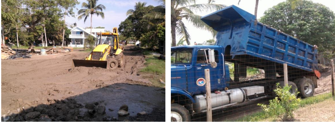
Imagen No.162.-Depósito, carga y acarreo del material producto del dragado, dentro del área del muro de contención (tarquina) en tierra.
