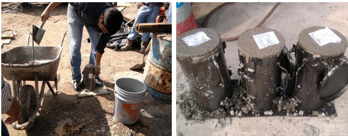
Imagen No.58.-Prueba del revenimiento y especímenes de concreto (cilindros), pruebas de resistencia de concreto de la trabe T-10.
