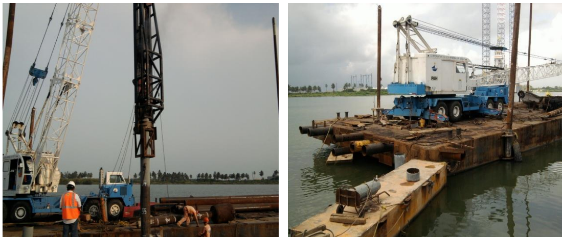
Imagen No.91.- Preparaciones previas de los pilotes, equipos y personal, para dar inicio al izado, trazos, verticalidad, posición e hincado del primer tramo de los pilotes vertical (PV).
