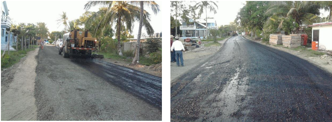
Imagen No.173.-Riego de impregnación y de liga aplicadas con la petrolizadora sobre la base del camino de acceso al muelle.
