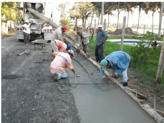
Imagen No.179.-Vaciado, extendido y pulido del concreto premezclado f'c=200\text{Kg/cm}^2 , para la construcción de las cunetas del camino de acceso al muelle.
