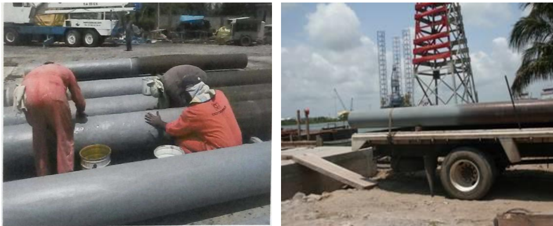
Imagen No.43.- Pintura primario epóxico RPB4 y acabado RE32, PEMEX RE-32 en Pilotes.
