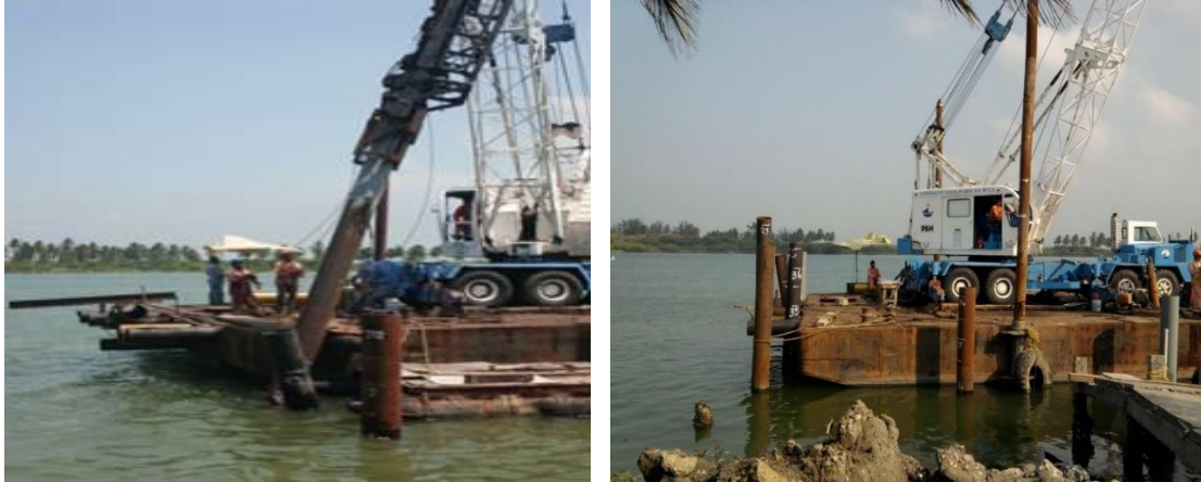
Imagen No.95.- Izado del segundo tramo de pilote inclinado, para el acoplamiento al primer tramo del pilote ya hincado, realizando el trazo, corte, descabece y aplicación de soldadura.
