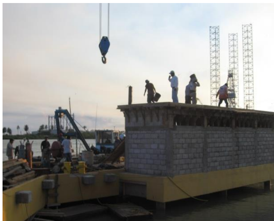
Imagen No.140.- Cimbra, acero de refuerzo y colado de losa de azotea de concreto, en la caseta de sistema contra incendios.
