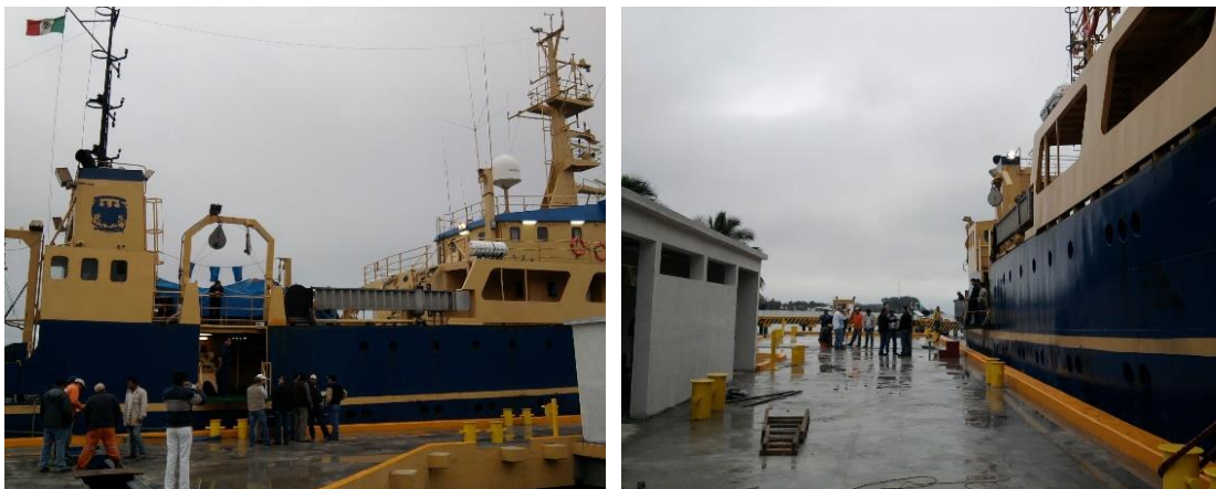
Imagen No.197.-Pruebas de atraque del Buque Oceanográfico de la UNAM, durante la terminación de los detalles iluminación y acabados en el muelle.
