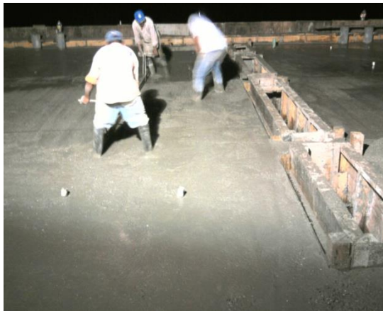
Imagen No.133.- Terminación de los colados de la trabe T-4, guarniciones y losa del muelle, con acabado pulido.
