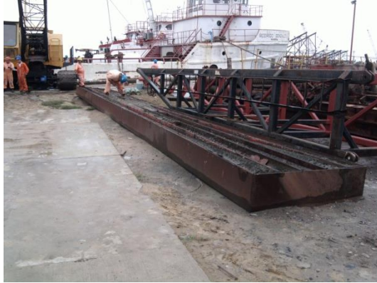
Imagen No.164.-Viga de acero de 15 m de longitud y buque, para nivelación del fondo marino, en el canal de navegación río Tuxpan.
