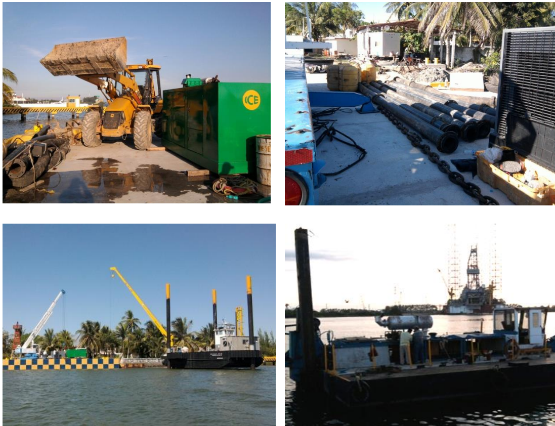
Imagen No.156.- Equipos y herramientas para los dragados (dragadora hidráulica, plataforma flotante, bomba JET, tuberías, generador motriz y retroexcavadora), en el muelle.
