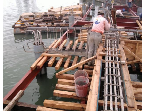
Imagen No.111.- Desplante de cimbra común de madera, habilitados y armados de pilotes, cabezales y traves en ejes 6, 5, y 4 entre los ejes D a G.
