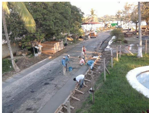
Imagen No.179.-Vaciado, extendido y pulido del concreto premezclado f'c=200\text{Kg/cm}^2 , para la construcción de las cunetas del camino de acceso al muelle.
