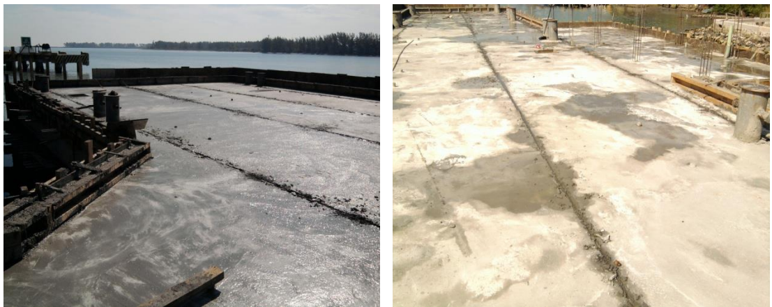
Imagen No.135.- Curado a base de riego de arena y agua en la trabe T-4, guarniciones y losa del muelle.
