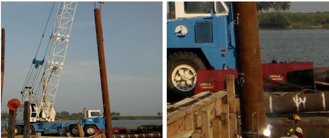
Imagen No.90.- Izado del segundo tramo de pilote para el acoplamiento al primer tramo del pilote ya hincado, realizando el trazo, corte, descabece y aplicación de soldadura.
