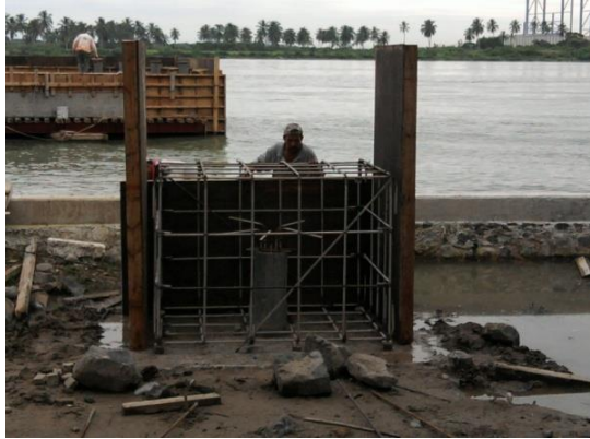
Imagen No.143.- Cimbra común de madera, acero de refuerzo, y colocación de bitas dobles de amarre del buque en tierra.
