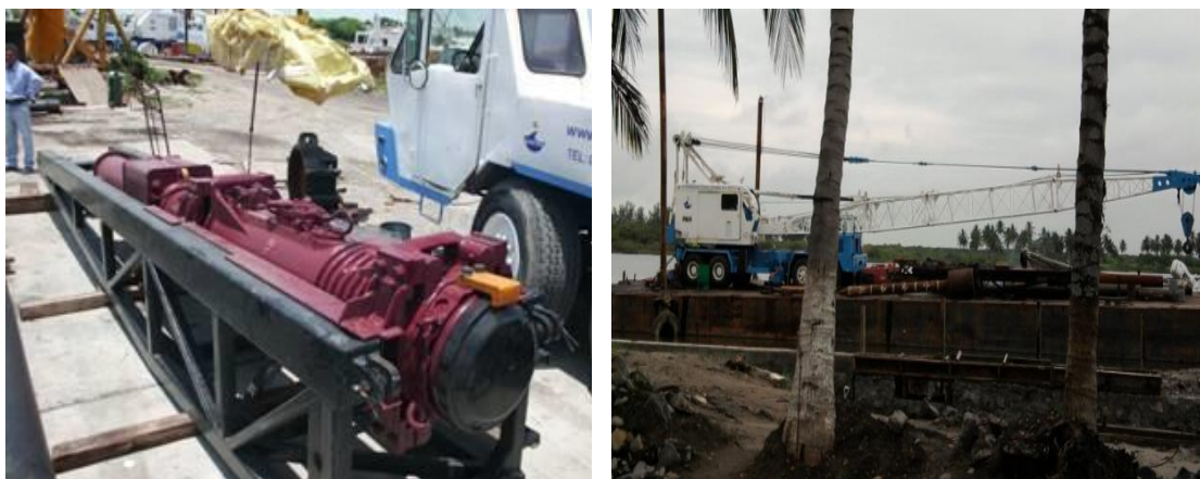
Imagen No.45.- Martillo hidráulico (DELMAG. 19-42), chalán (balsa) con grúa, equipos y materiales llegan a la obra.
