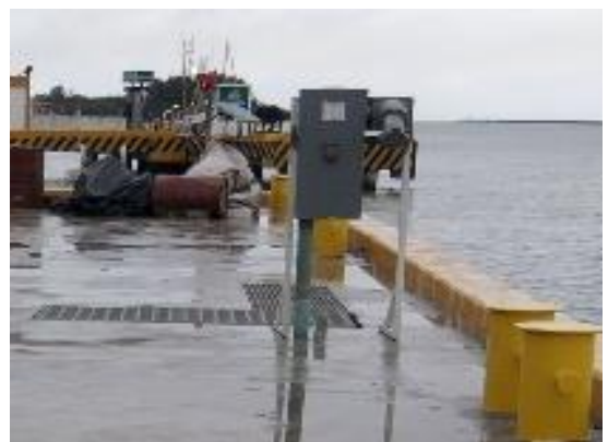
Imagen No.194.- Acometida eléctrica en la caseta contraincendios y el contacto de toma de corriente durante el atraque del Buque Oceanográfico.
