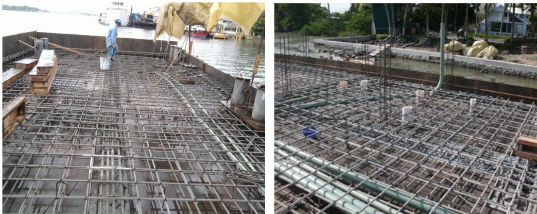
Imagen No.123.- Colocación de bitas dobles, tuberías para las instalaciones eléctricas, y acero de refuerzo para la losa del muelle.
