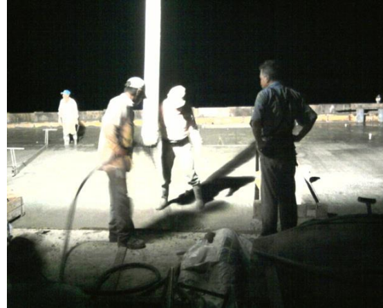
Imagen No.132.- Colado de la trabe T-4 y losa del muelle en el eje G del eje 5 al 13 y del eje 13 desde G a D.
