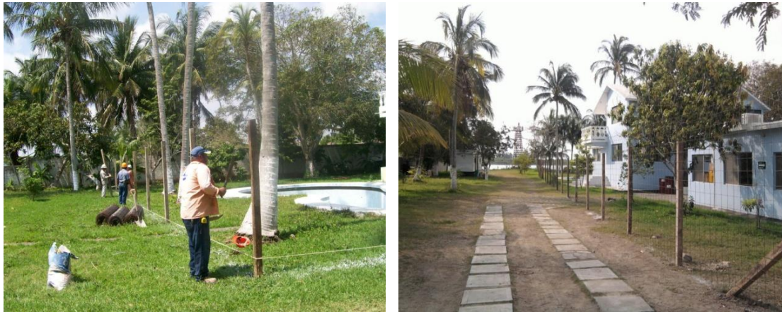
Imagen No.23.- Tapial para protección a las oficinas en servicio.
