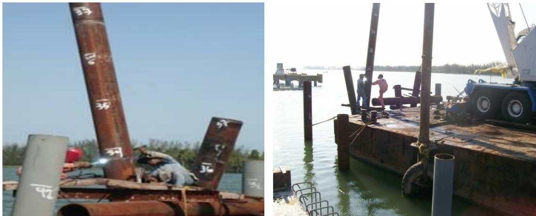
Imagen No.94.- Izado del segundo tramo de pilote y acoplamiento con el primero, realizando el trazo, corte, descabece y aplicación de soldadura.
