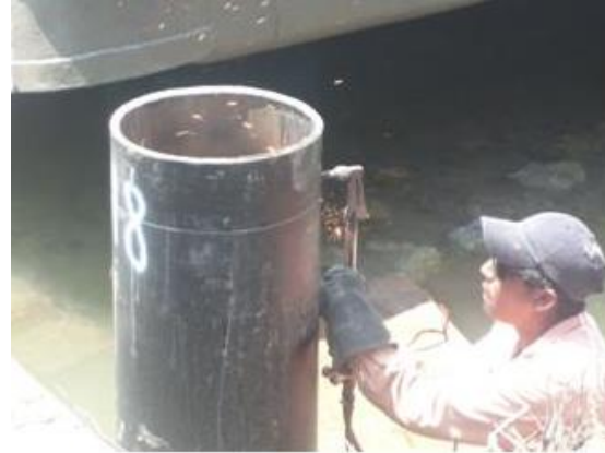
Imagen No.73.- Hincado y descabece de pilotes verticales de acero en el río.
