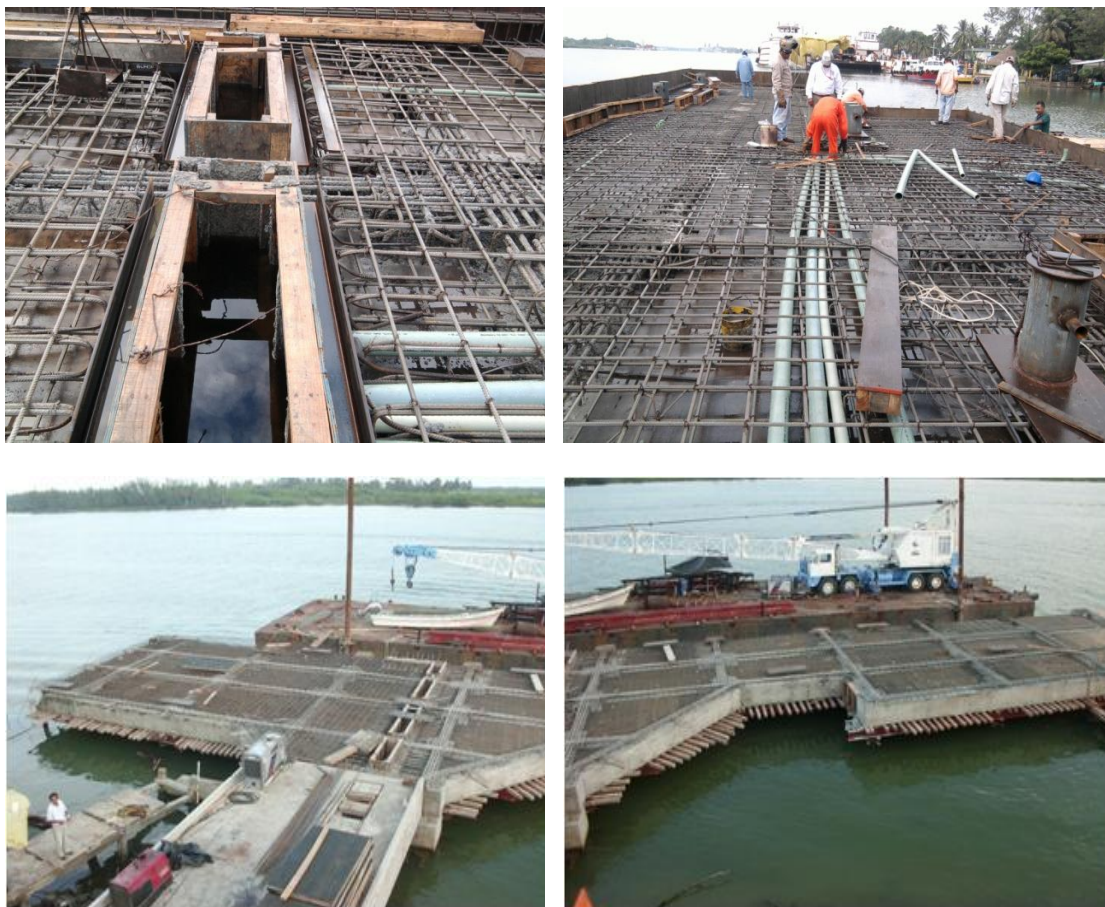
Imagen No.121.- Cimbra, tuberías de PVC, ángulo estructural en trincheras y registros para las instalaciones eléctricas e hidráulicas sobre la losa del muelle.
