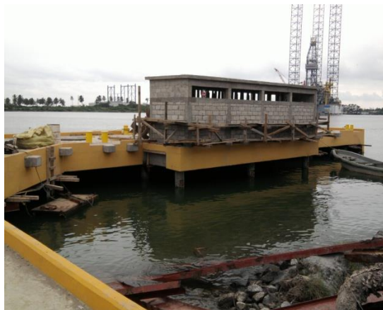
Imagen No.140.- Cimbra, acero de refuerzo y colado de losa de azotea de concreto, en la caseta de sistema contra incendios.
