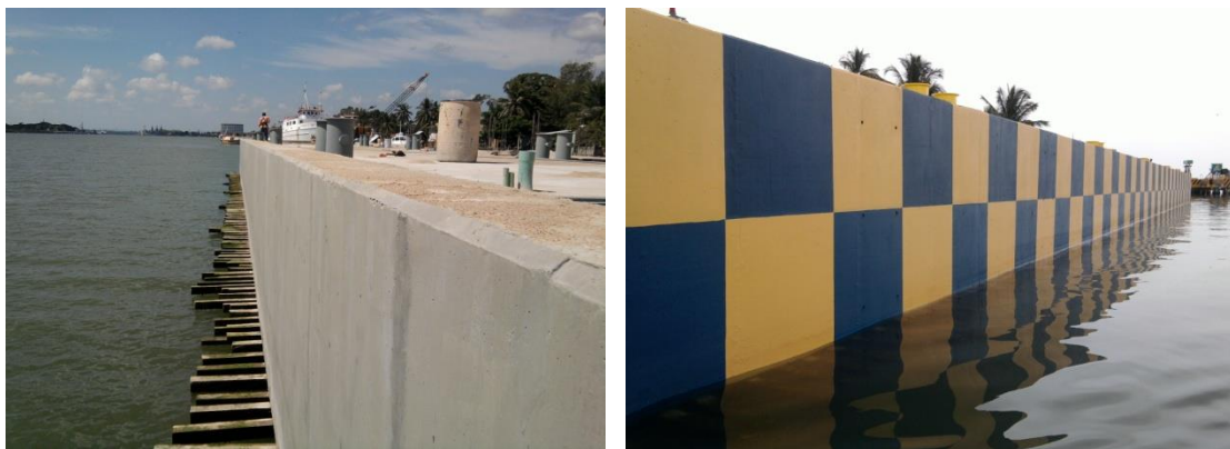
Imagen No.146.- Limpieza, trazo, y aplicación de pintura color azul y oro, a base de pintura inorgánica de zinc autocurante silicato base de solvente, marca COMEX, en pantalla de atraque del muelle.
