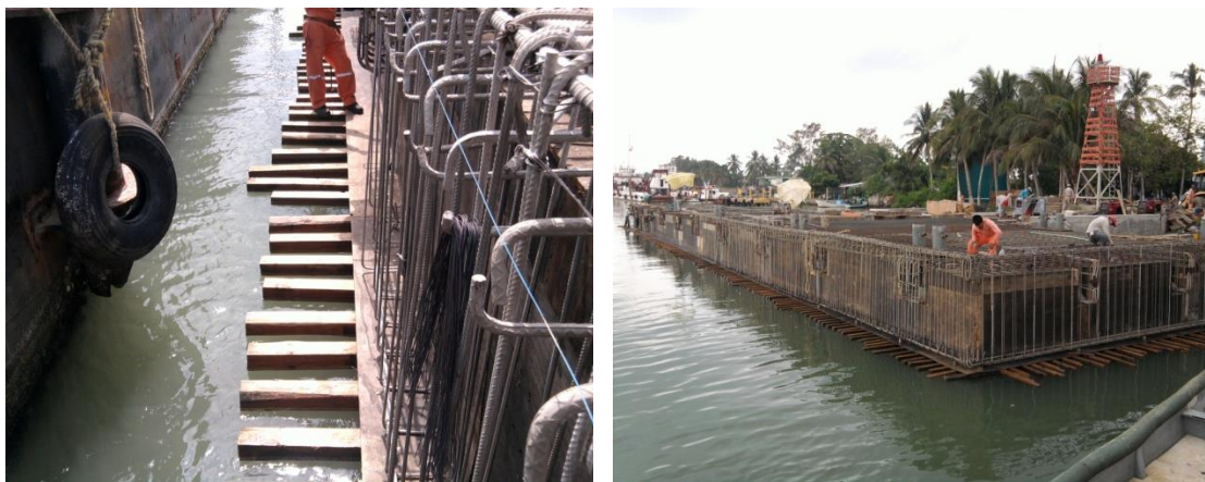
Imagen No.120.- Cimbra de madera y acero de refuerzo para el armado de la trabe pantalla de atraque (T-4).
