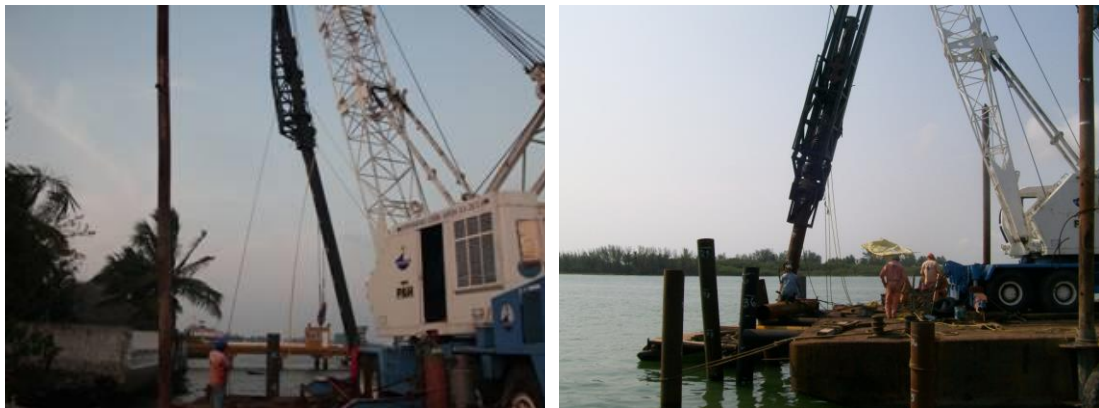
Imagen No.93.- Hincado del primer tramo del pilote inclinado (PI-28) con el martillo hasta dejarlo un metro fuera del mar, para el acoplamiento del segundo tramo.
