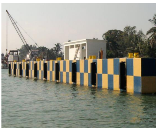
Imagen No.148.- Instalación de diez defensas marinas en muelle del buque y barandal con dos defensas en muelle de lanchas.
