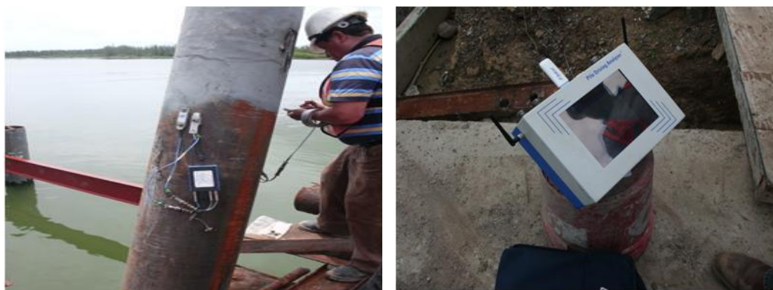
Imagen No.85.- Hincado del segundo tramo del pilote inclinado PI-18 con el martillo hidráulico y toma de las lecturas de las Pruebas de Carga Dinámica.
