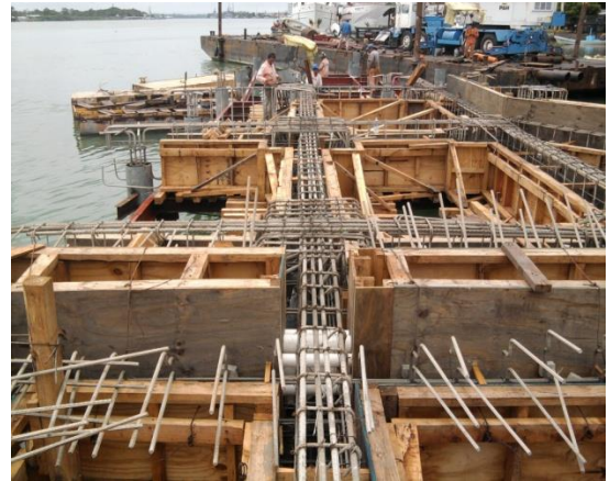
Imagen No.112.- Cimbra con canalones de madera y armados de acero de refuerzo de pilotes, cabezales y traves, de ejes 6, 5, y 4 entre ejes D a G.
