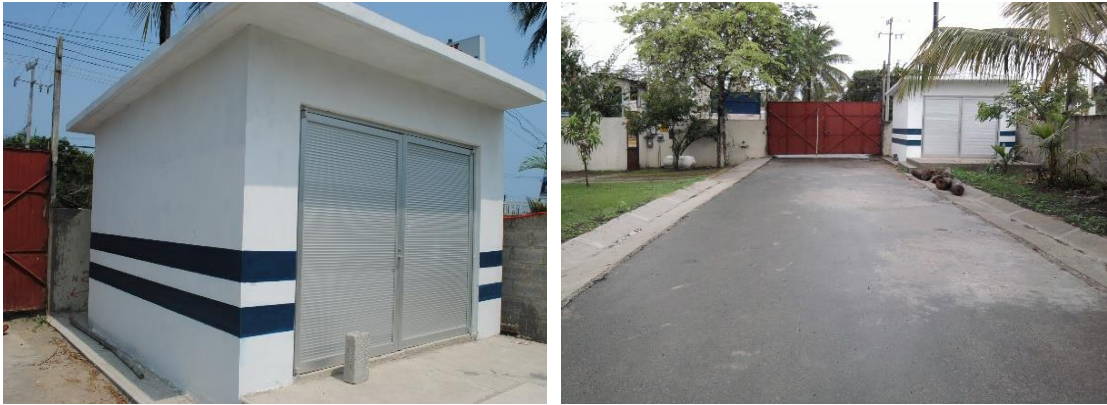
Imagen No.186.- Caseta de la subestación eléctrica en la entrada del predio de la Base de Operaciones Oceanográficas y del muelle del buque "Justo Sierra".
