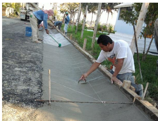
Imagen No.180.-Escobillado y elaboración de juntas de contracción en las cunetas del camino de acceso al muelle.
