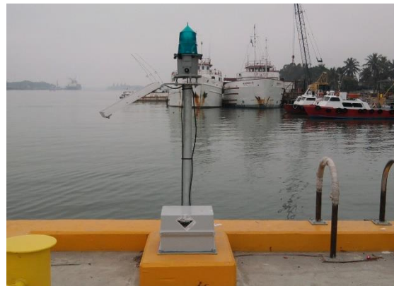
Imagen No.193.-Acometida eléctrica para la iluminación del muelle para el Buque Oceanográfico.
