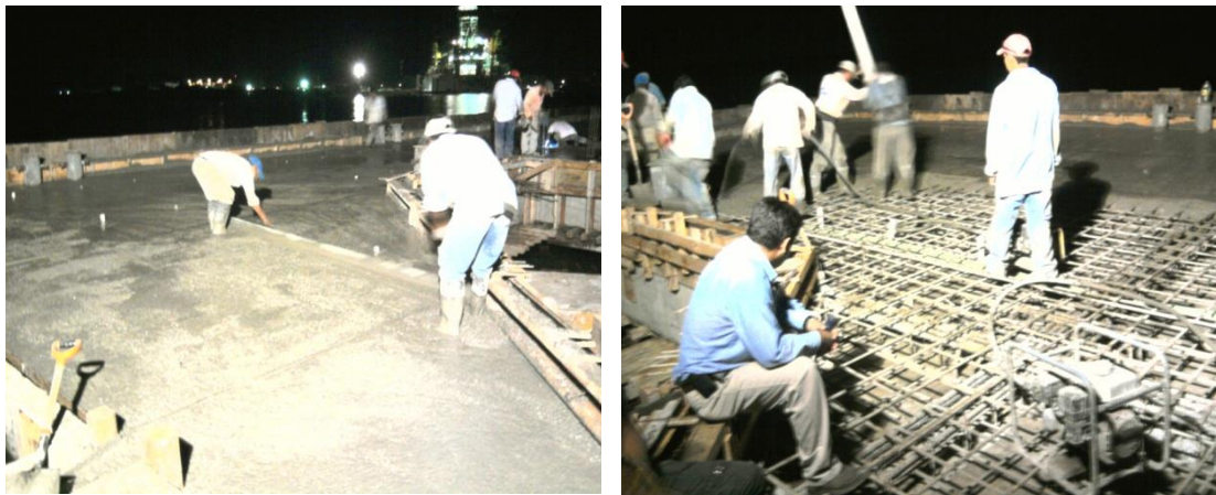
Imagen No.131.- Continuando con el colado en la trabe T-4 y losa en el eje G del eje 5 al 13, y del eje 13 desde G a D, terminando el colado de la trabe T-4.
