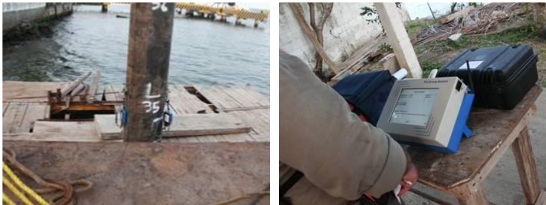
Imagen No.84.- Hincado del segundo tramo del pilote vertical PV-29 y toma de las lecturas de las Pruebas de Carga Dinámica.
