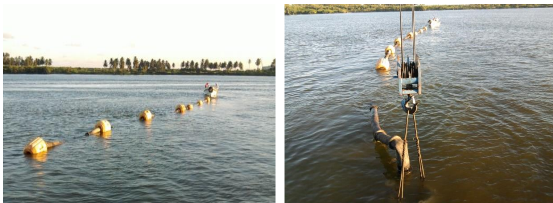
Imagen No.157.-Acoplamiento e instalación de las lingadas en el área de dragado, (dársena y área de maniobras para el buque), en el río Tuxpan.
