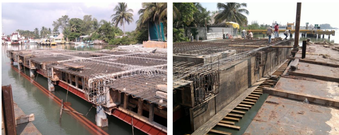
Imagen No.118.- Obra falsa de apoyo de la cimbra de madera para la trabe pantalla de atraque (T-4), y acero de refuerzo para el armado de la losa del muelle, entre los ejes del 13 al 1 y del D a G.
