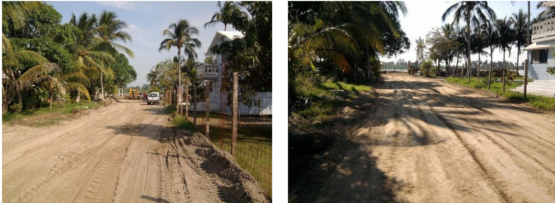
Imagen No.167.- Corte Transversal y compactación del Camino de Acceso al Muelle.
