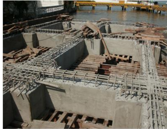
Imagen No.108.- Descimbrado y curado de los cabezales y traveses, entre los ejes 13, 12, 11, y 7 del eje D a G, del muelle.
