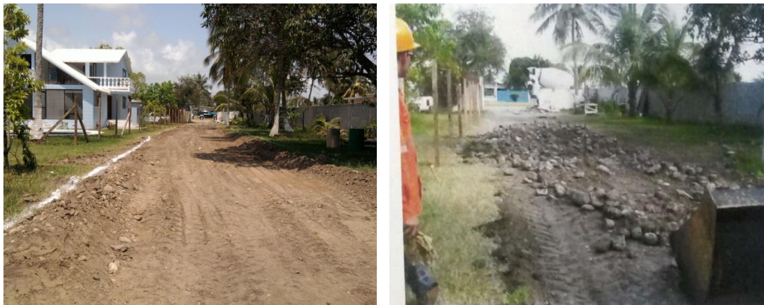
Imagen No.36.- Excavación y mejoramiento a base de gravarena del camino de acceso al muelle.
