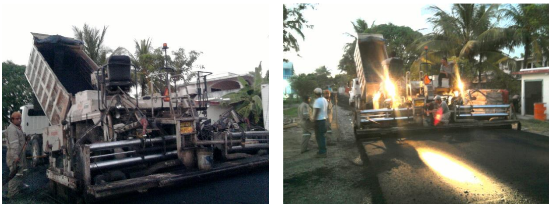
Imagen No.174.-Suministro y colocación de la carpeta asfáltica de 10cm de espesor, aplicada con camión volteo y pavimentadora sobre el camino de acceso al muelle.
