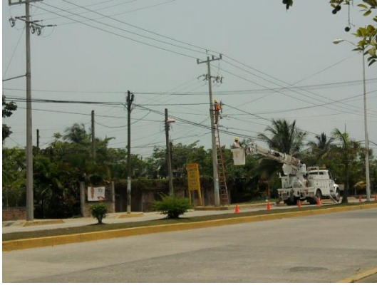
Imagen No.195.-Acometida aérea desde un poste de la red de suministro CFE, a un registro frete a la caseta de la subestación eléctrica del predio de la Base de Operaciones Oceanográficas del Buque Oceanográfico de la UNAM.
