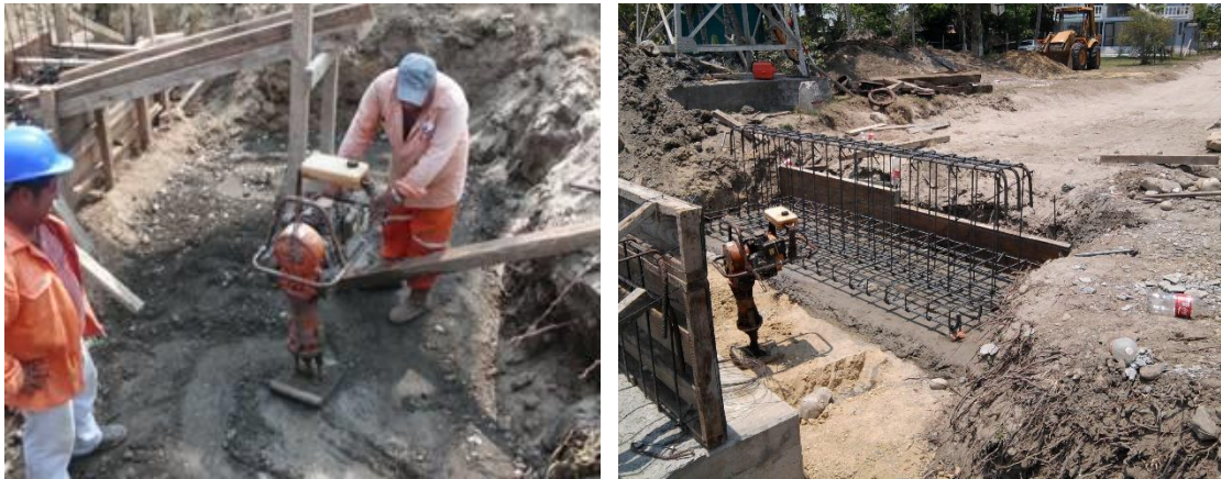
Imagen No.60.-Mejoramiento de terreno, plantilla de concreto y acero de refuerzo para la trabe de la rampa de acceso al muelle.
