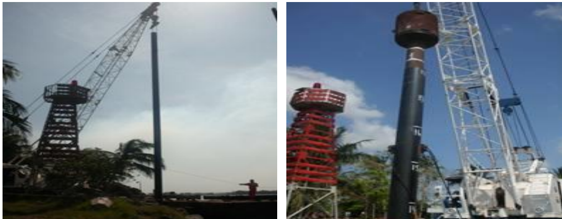
Imagen No.52.- Izado e hincado de los pilotes con pilón (5.235Ton.), para la cimentación de la trabe T-10.
