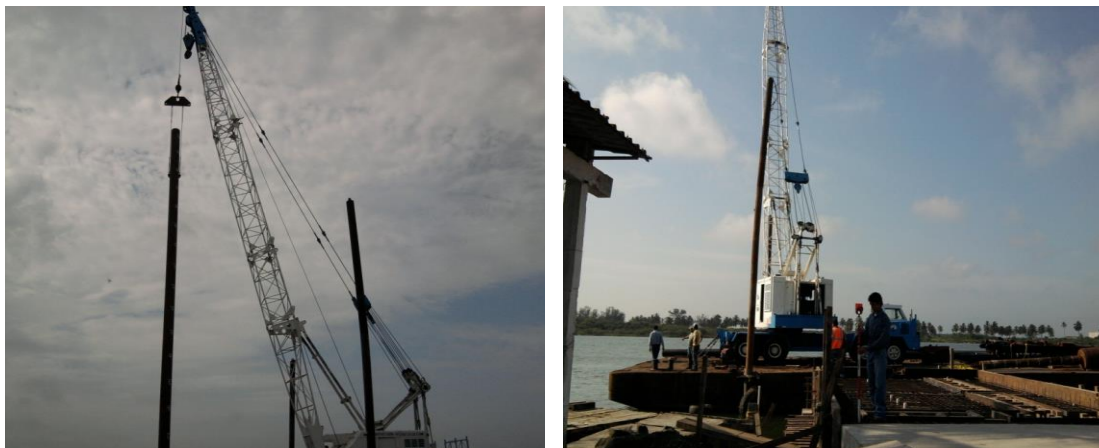
Imagen No.88.- Izado, trazos, verticalidad, posición e hincado del primer tramo del pilote vertical (PV-29).
