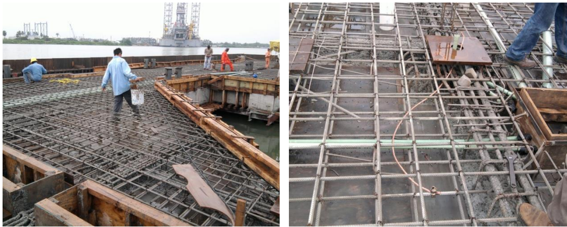
Imagen No.122.- Cimbra en la trabe T-4 y guarniciones, colocación de placa base para postes de alumbrado y balizas de señalización en el muelle.
