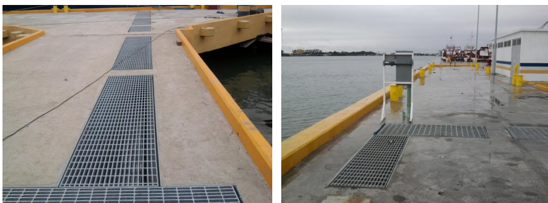
Imagen No.153.- Colocación de rejilla tipo Irving en la trinchera de servicios (instalaciones eléctricas e hidráulicas), en el muelle.
