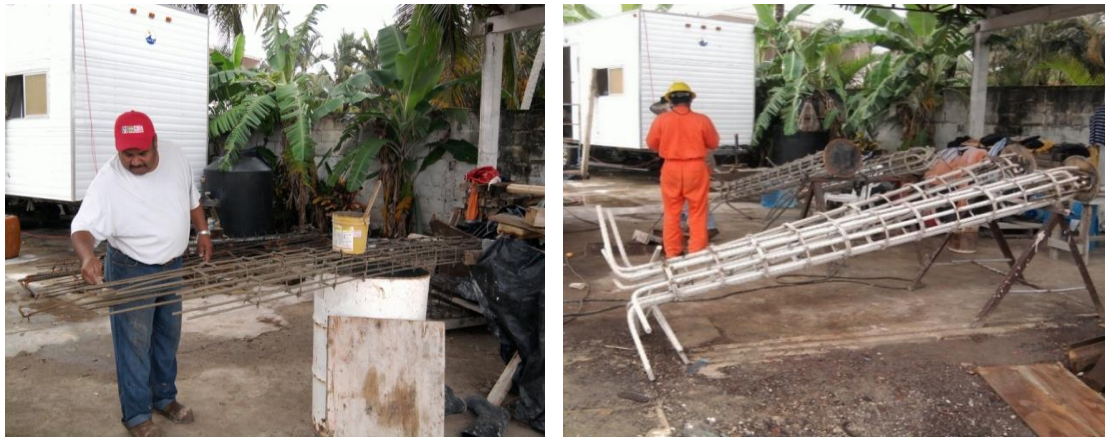
Imagen No.48.- Pintura primario RPB4 y acabado RE32, en el acero de refuerzo.
