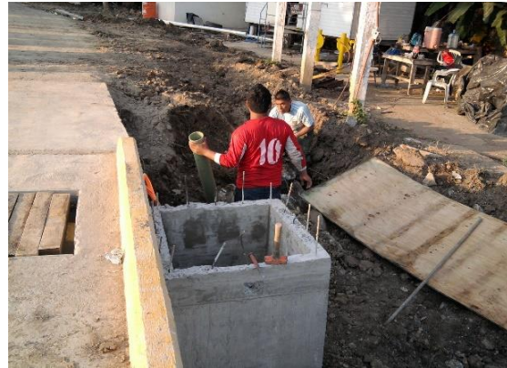
Imagen No.193.-Canalizaciones para las acometidas eléctricas de la iluminación del muelle, equipos de la caseta contraincendios, y para el contacto de toma de corriente del buque oceanográfico.
