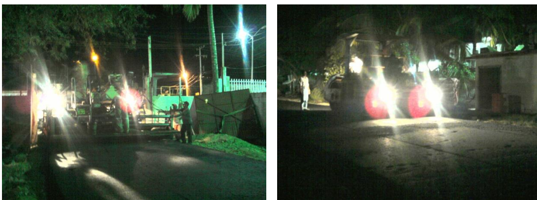
Imagen No.175.-Terminación de la colocación y compactación de la carpeta asfáltica de 10cm de espesor, con la pavimentadora y rodillo metálico vibratorio liso en el camino de acceso al muelle.
