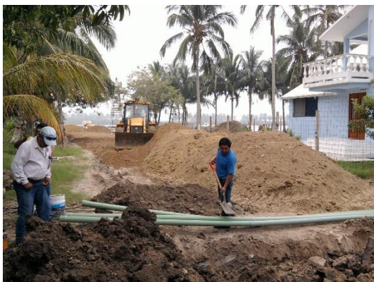
Imagen No.182.-Trabajos previos de las instalaciones eléctricas para los cruces en el camino de acceso al muelle.
