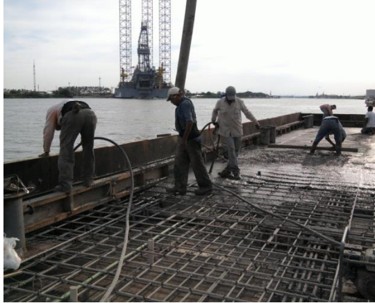
Imagen No.128.- Colocación y acomodo del concreto con los vibradores, extendiendo el concreto con pala, cuchara y regla para dar los niveles y acabado pulido con llana metálica en la trabe T-4, guarniciones y losa del muelle.
