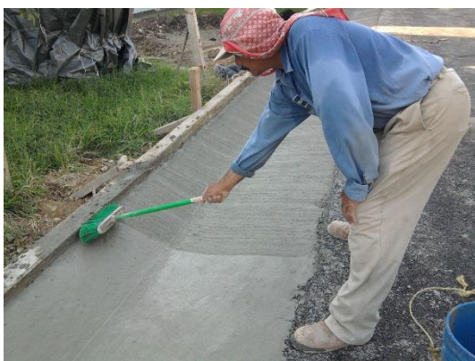
Imagen No.180.-Escobillado y elaboración de juntas de contracción en las cunetas del camino de acceso al muelle.
