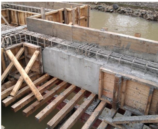
Imagen No.109.- Descimbrado de los tapones en traveses de los ejes 13, 12, 11 y 7 entre ejes D a G, tramos pendientes para continuar con los armados y colar monóticamente con la trabe (T-4) pantalla.
