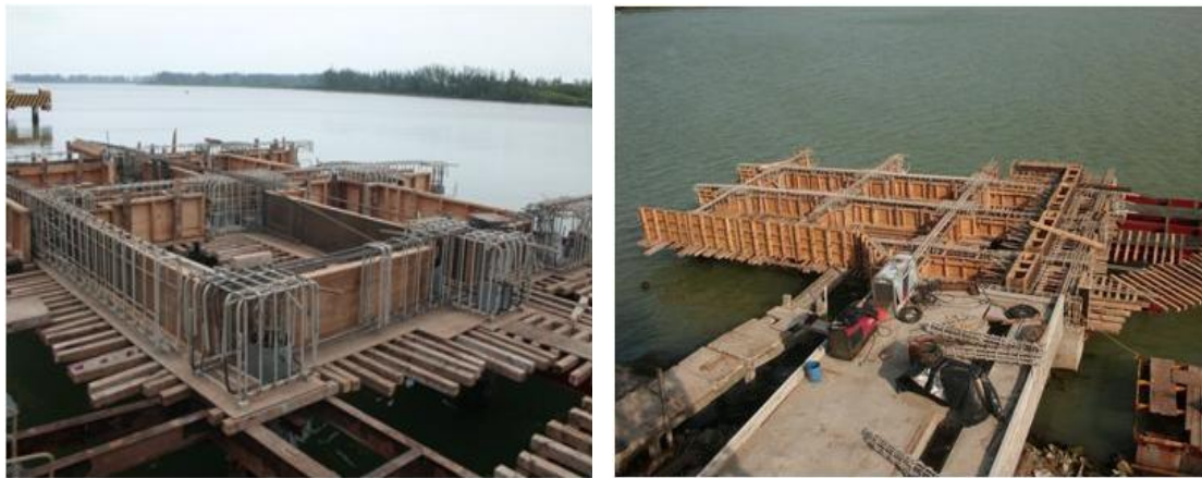
Imagen No.105.- Colocación de cimbra común de madera con desmoldante, así como el habilitado y armado de acero de refuerzo en pilotes, cabezales y traveses de los ejes 13, 12, 11 y 7 entre los ejes D a G.
