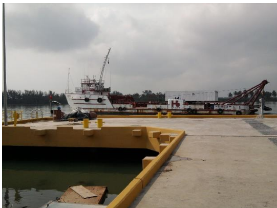
Imagen No.165.-Buque con viga de acero realizando rastrillado, dando varias pasadas frente al muelle del buque Justo Sierra, para dar nivelación en el canal de navegación interior del río Tuxpan.
