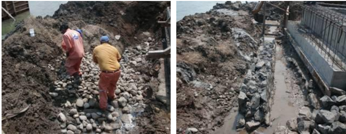
Imagen No.69.- Relleno de piedra limpia de río (piedraplen), base de desplante del muro de contención.
