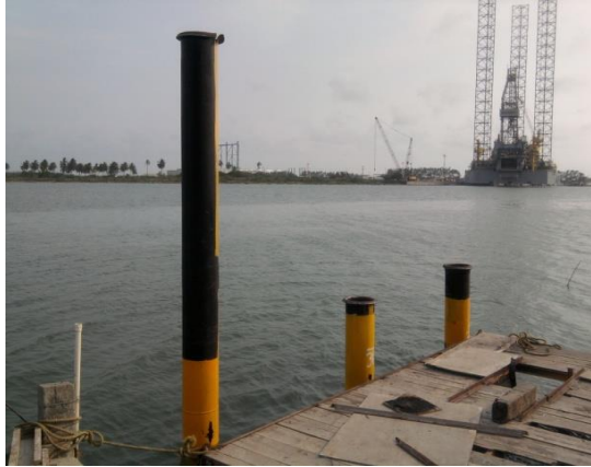
Imagen No.73.- Hincado y descabece de pilotes verticales de acero en el río.
