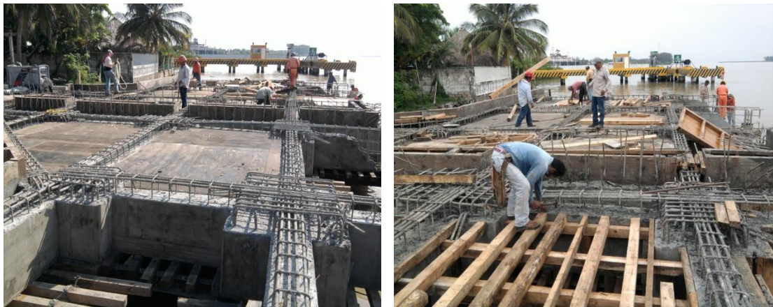
Imagen No.117.- Cimbra de madera para la losa del muelle, en los ejes del 13 al 1 entre los ejes D a G.
