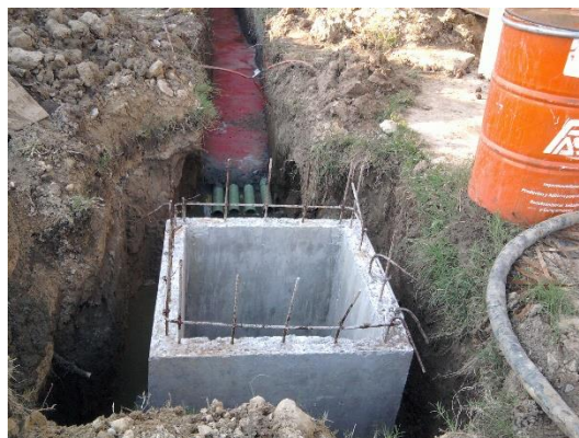
Imagen No.182.-Trabajos previos de las instalaciones eléctricas para los cruces en el camino de acceso al muelle.
