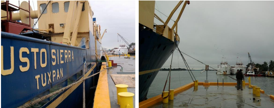
Imagen No.199-Sistema de amarres (largos y cortos) en bitas, para la permanencia y/o estadía del Buque Oceanográfico, en el muelle de la Base de Operaciones Oceanográficas de la UNAM.
