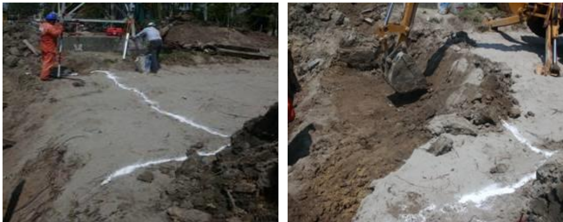
Imagen No.51.-Trazos, niveles y excavación para la cimentación de la Trabe T-10.
