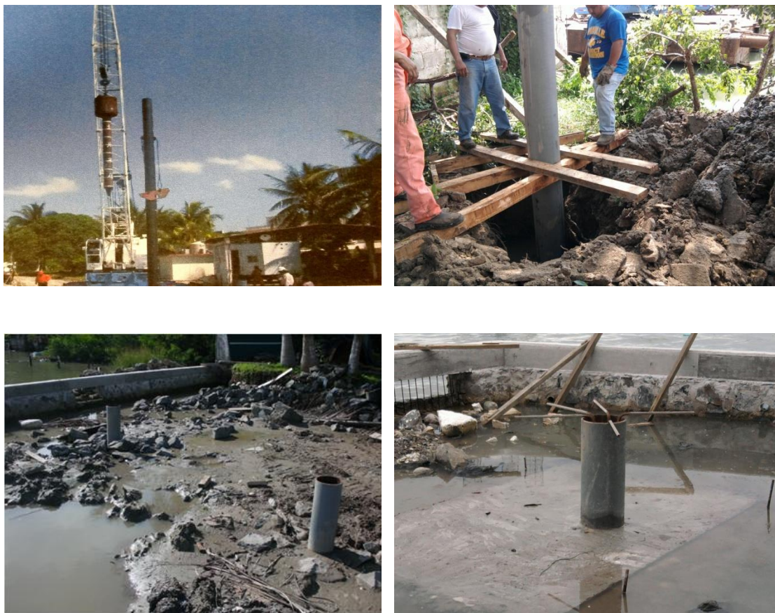
Imagen No.142.- Hincado de pilotes vertical de 10" de diámetro y colocación de plantilla de concreto, para las bitas dobles de amarre del buque en tierra.
