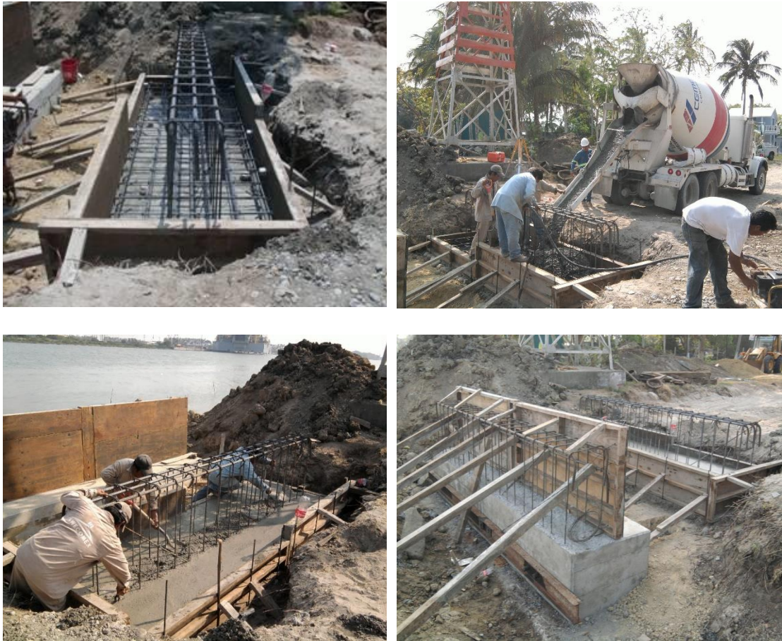
Imágenes No.61.-Acero, cimbra y colocación de concreto a tiro directo, a nivel de la zapata de la trabe de la rampa de acceso al muelle.
