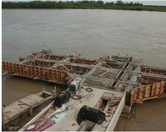
Imagen No.108.- Descimbrado y curado de los cabezales y traveses, entre los ejes 13, 12, 11, y 7 del eje D a G, del muelle.
