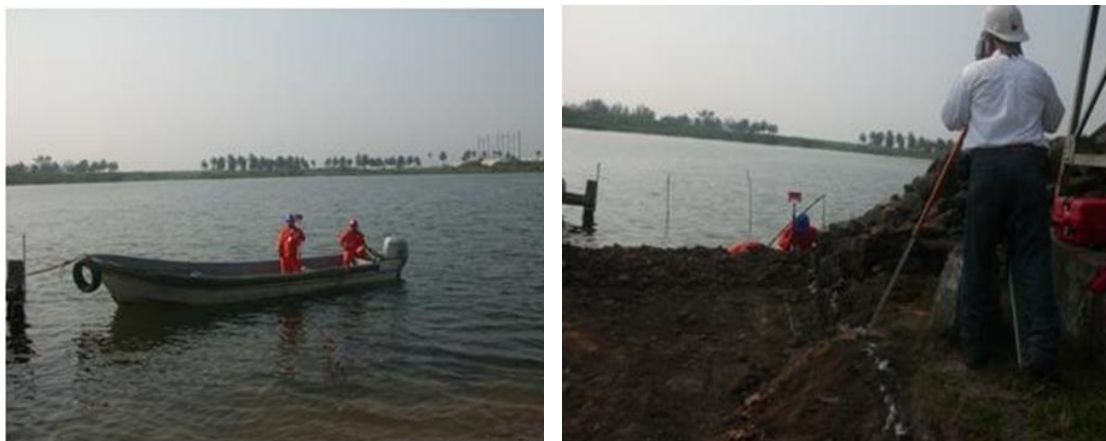
Imagen No.28.- Trazo y Posición de Pilotes en el río con Estación Total y GPS.
