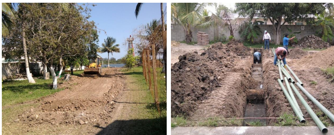
Imagen No.35.- Despalme, excavación y cruces canalizaciones eléctricas en el camino acceso al muelle con la retroexcavadora.
