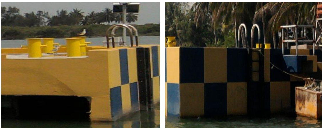
Imagen No.149.- Instalación de escaleras marinas en muelle del buque.
