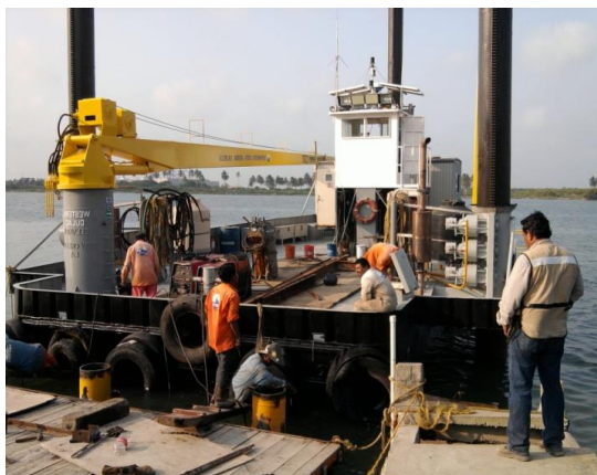
Imagen No.74.- Habilitado, colocación y soldado de ménsulas, para apoyo de la obra falsa de la trabe T-8 en el río.
