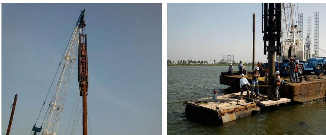
Imagen No.89.- Hincado del primer tramo del pilote con el martillo hasta dejarlo un metro fuera del nivel del río, para el acoplamiento del segundo tramo.
