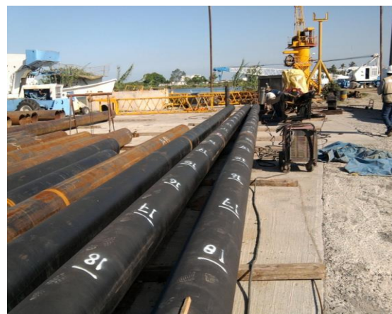
Imagen No.42.- Habilitado y marcado de pilotes para control de los hincados.
