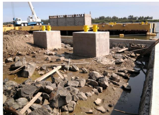
Imagen No.144.- Aplicación de pintura en bitas dobles de amarre para el buque en tierra.
