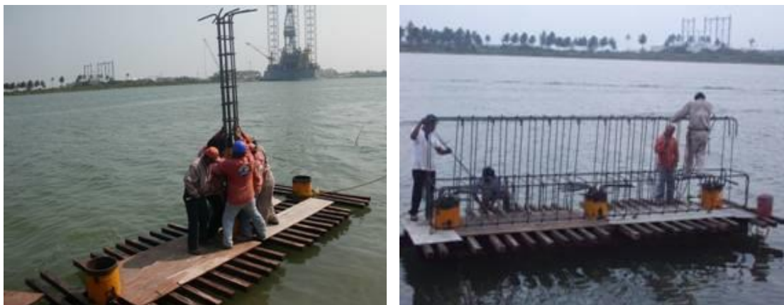
Imagen No.75.- Colocación del acero de refuerzo en pilotes y trabe T-8.
