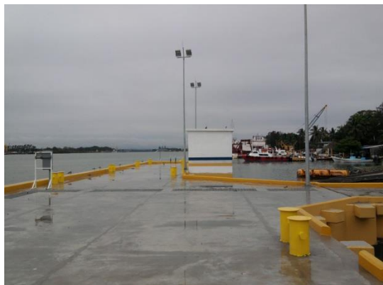
Imagen No.147.- Aplicación de pintura para tráfico pesado en guarniciones del muelle.
