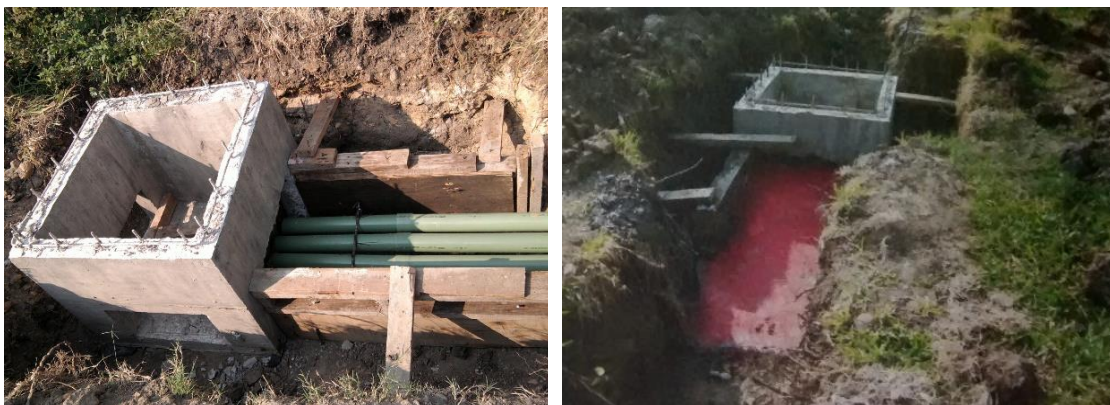
Imagen No.191.- Colocación de registro prefabricados y encofrado de las tuberías de llegada a los registros eléctricos, para la acometida eléctrica de la subestación al muelle.
