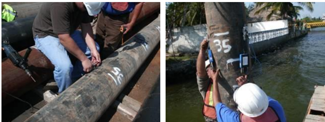
Imagen No.83.- Preparaciones de la instalación de sensores en los segundos tramos de los pilotes a hinca, Pruebas de Carga Dinámica.
