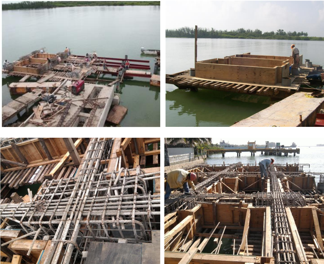
Imagen No.101.- Cimbra de madera en traves y cabezales, así como los habilitados y armados de los pilotes, cabezales y traves de los ejes 13, 12, 11 y 7 entre los ejes D a G.
