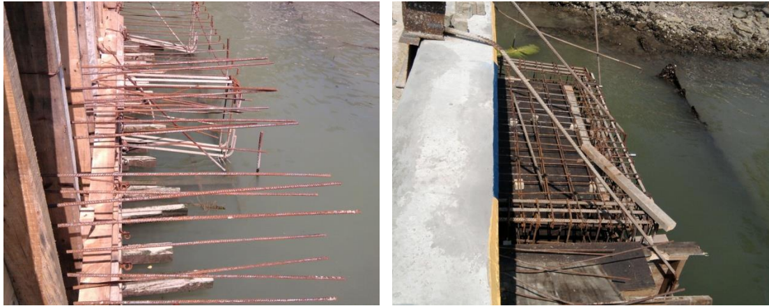
Imagen No.136.- Acero de refuerzo y cimbra común para la construcción de las trabes (T-1), losa y escalera, para el muelle de lanchas.
