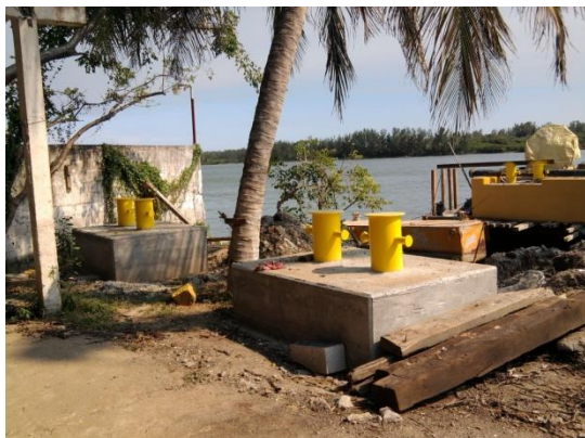
Imagen No.144.- Aplicación de pintura en bitas dobles de amarre para el buque en tierra.
