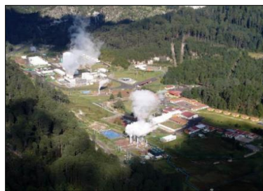
FIGURA 2.14 Central geotérmica Los Azufres (Fuente: Proyecto IMPULSA IV, Instituto de Ingeniería, UNAM).
