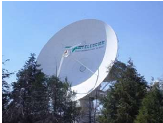
Figura 10 Ejemplo Estación Terrena Fija
