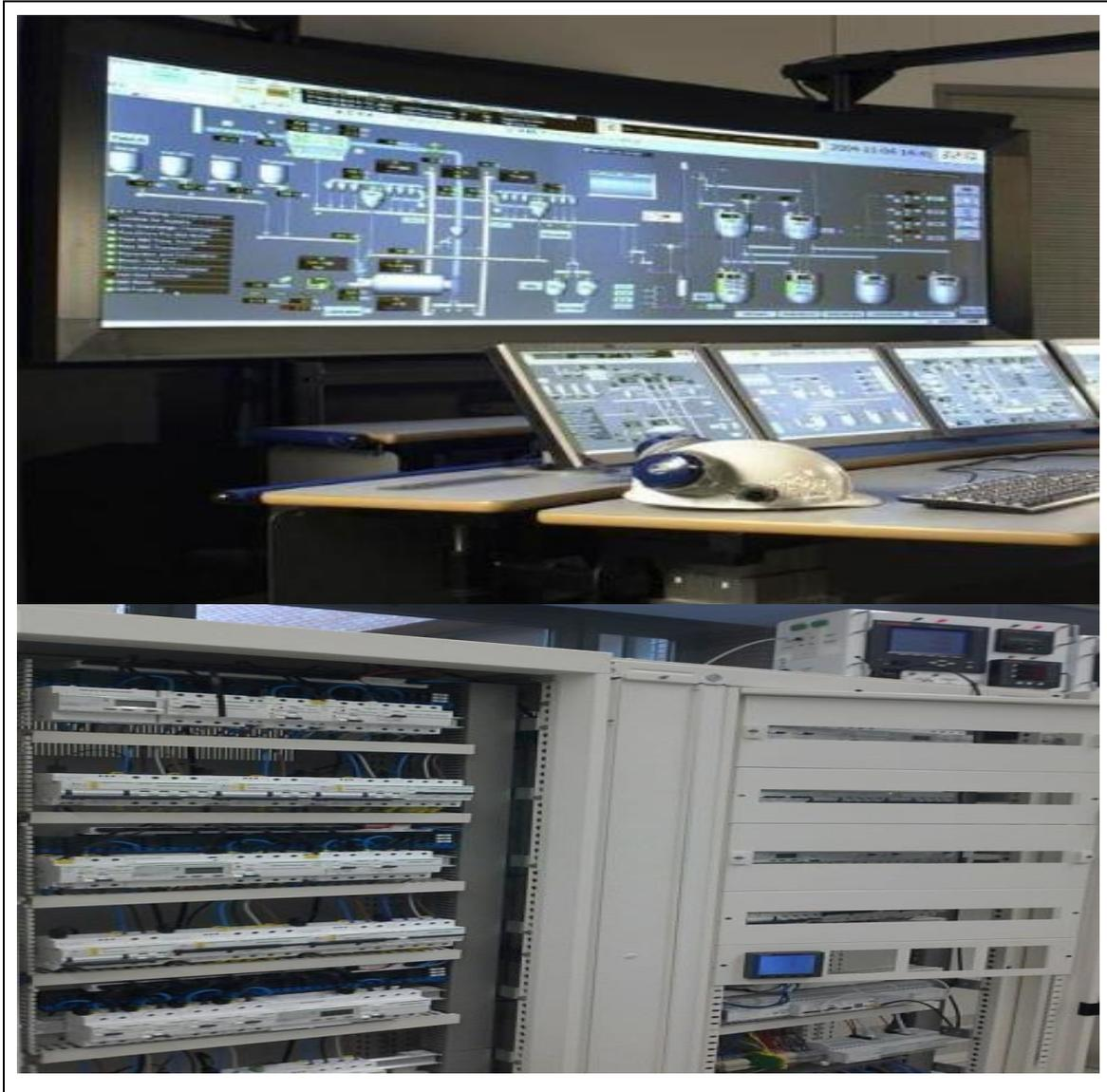
**IMAGEN 5: Cuarto de Control y Sistema de Control Distribuido**
