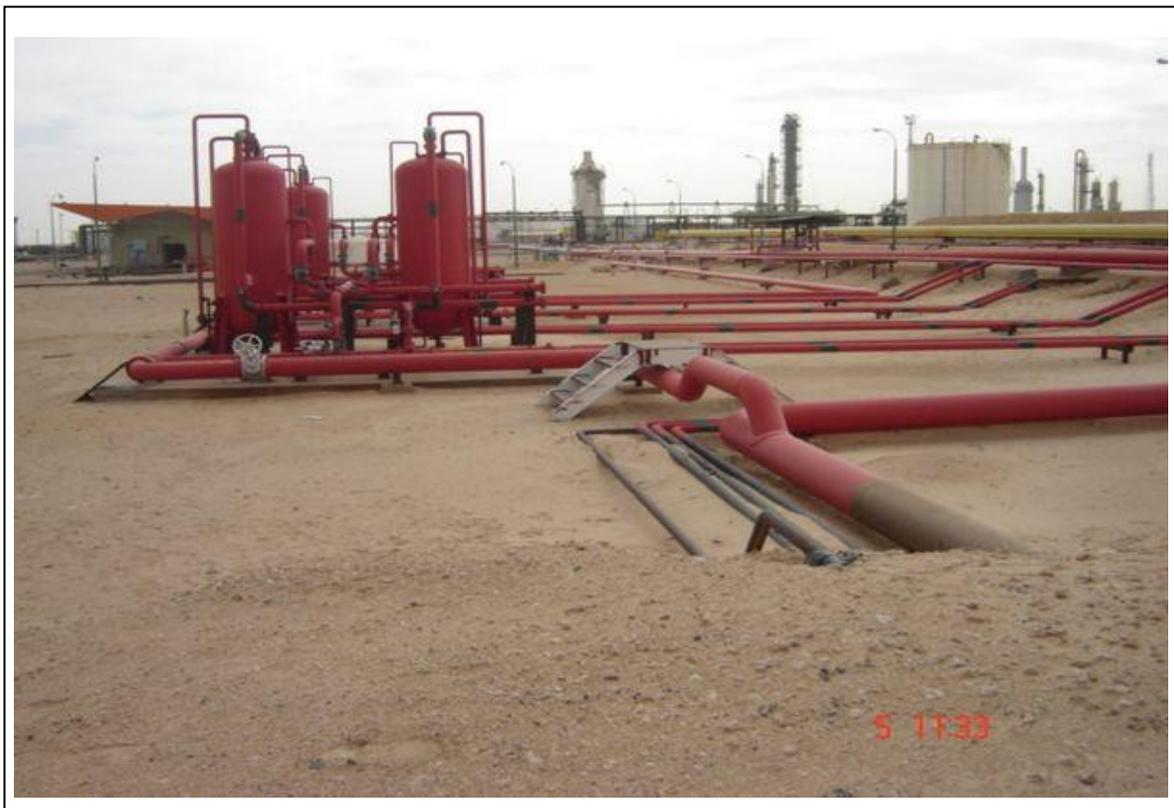
**IMAGEN 15:** Tuberías para Sistema Contra Incendio
