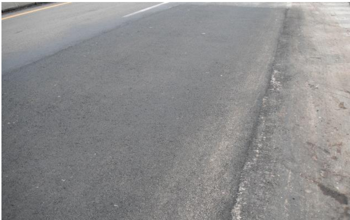
Figura 59 – Ejemplo de superficie de rodamiento al final de los trabajos de bacheo profundo con sobrecarpeta.
