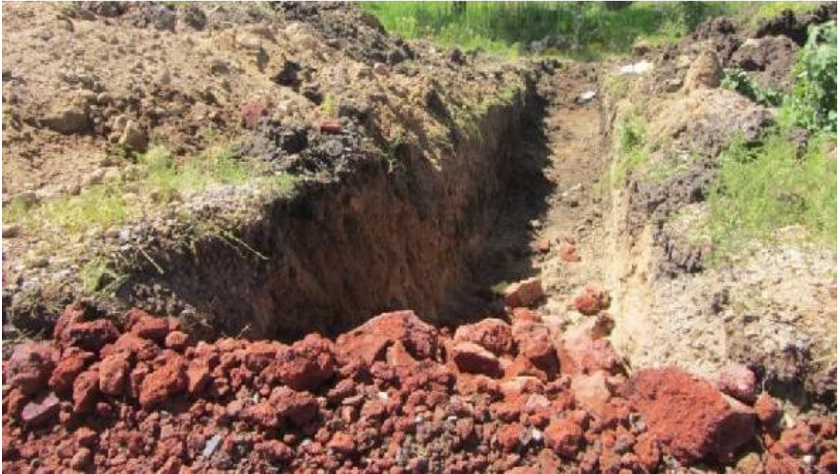
Figura 48 – Preparación de zanja para dren lateral en sitios de saturación de humedad, octubre de 2012.
