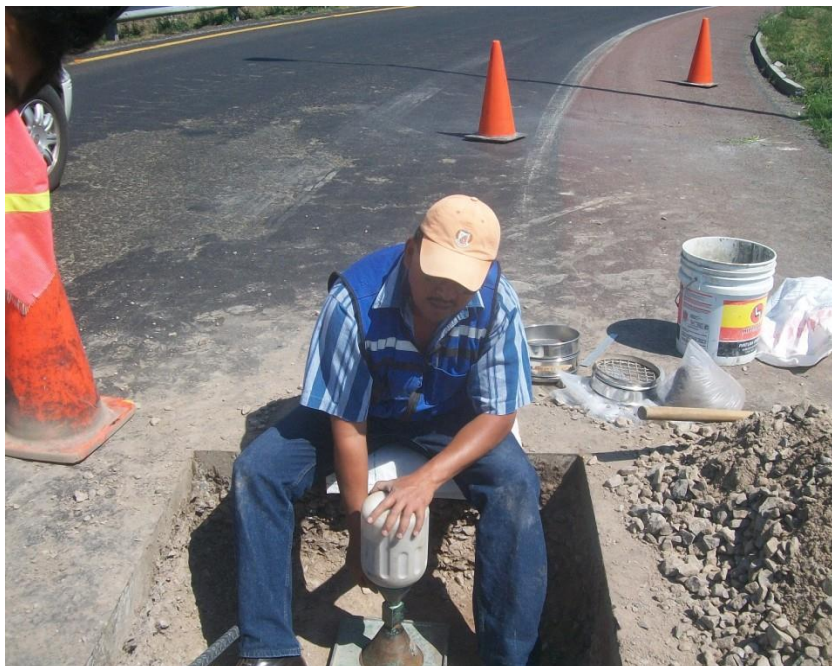
Figura 35 – Extracción de muestra en capa de base hidráulica para análisis en laboratorio, agosto de 2012.
