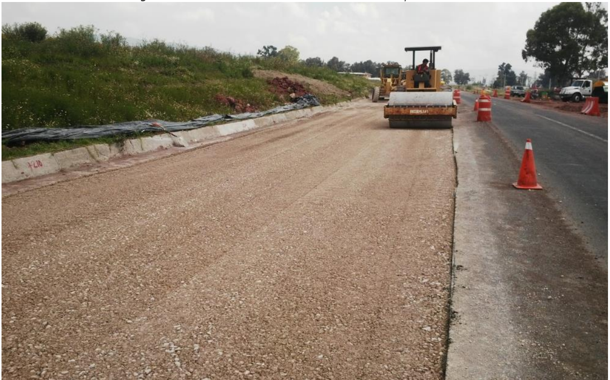
Figura 73 – Colocación de la capa de subbase granular hidráulica.
