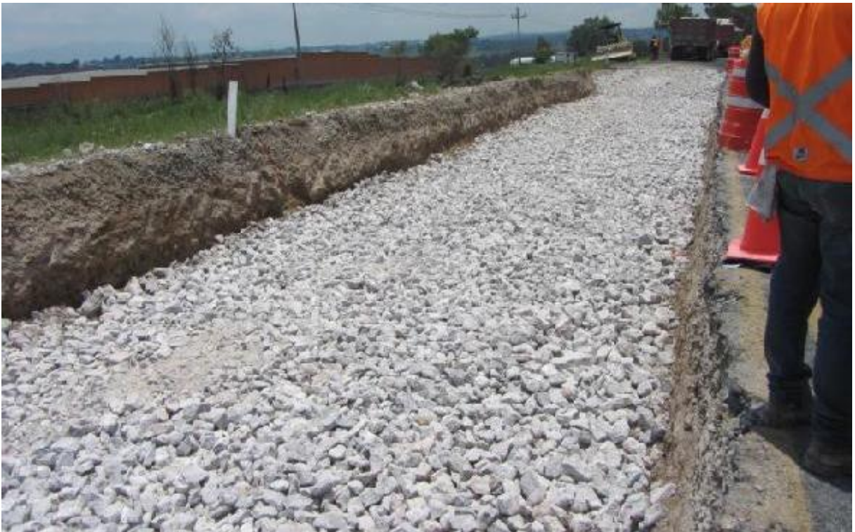
Figura 69 – Colocación de material de para la capa de pedraplén filtrante sobre terracerías compactadas.
