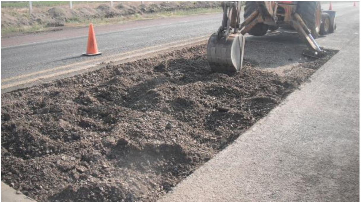
Figura 52 – Retiro de la capa de base granular hidráulica.
