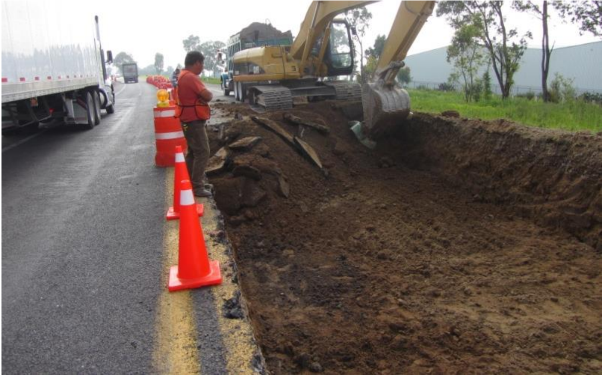
Figura 67 – Remoción de las capas del pavimento degradado hasta la profundidad del nuevo proyecto.
