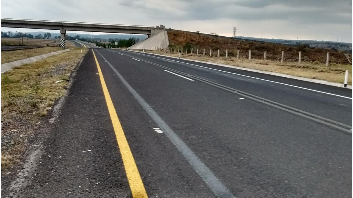
Figura 83 – Carril de alta velocidad (izquierdo) en estructura propuesta en servicio desde 2012.
