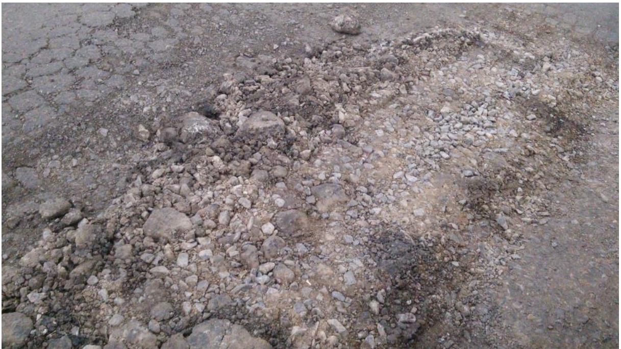
Figura 63 – Detalle del bache rellenado con gravas.
