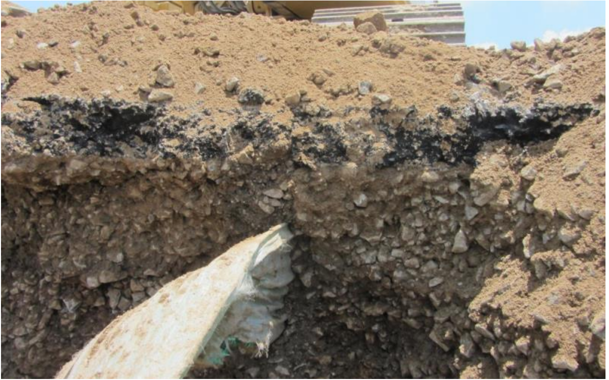
Figura 68 – Retiro de los subdrenes laterales en los tramos donde se encontraron.
