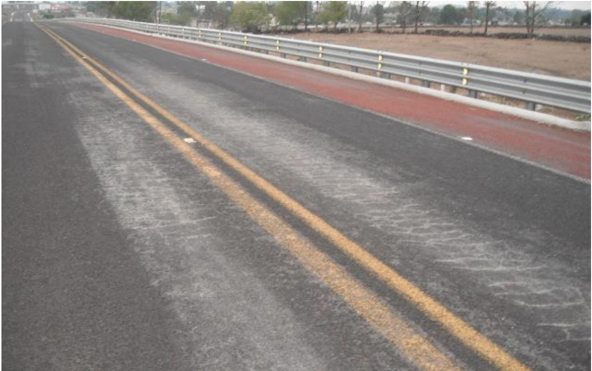
Figura 24 – Carpeta asfáltica km 47+500 cuerpo único, abril de 2012.
