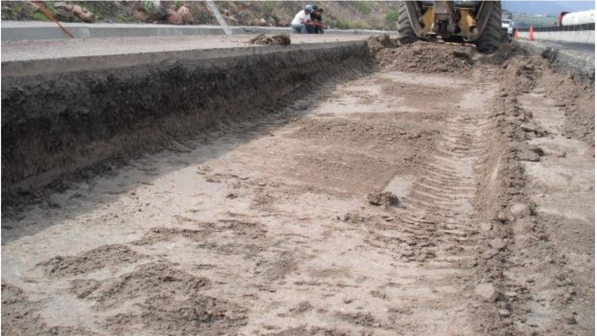
Figura 53 – Retiro de la capa de subbase granular hidráulica y sub-rasante saturados.
