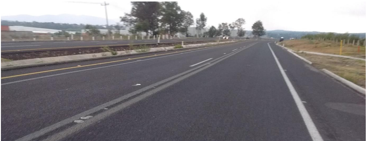
Figura 84 – Sección propuesta sin problemas después de 5 años de servicio.
