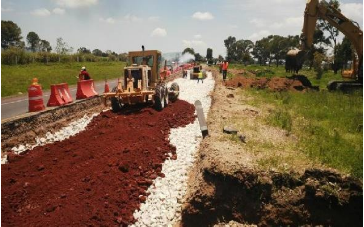
Figura 70 – Colocación de capa de sub-yacente en materiales filtrantes gruesos y ligeros.
