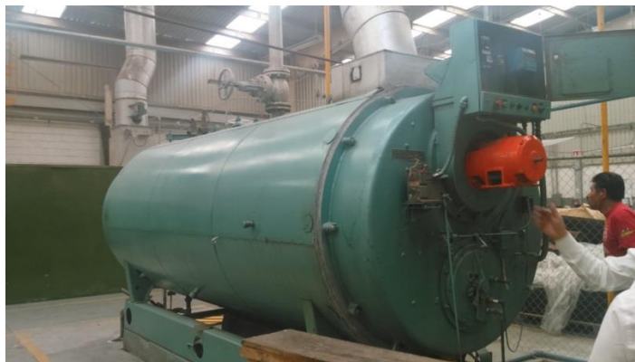
Ilustración 30 Control Aire- combustible
