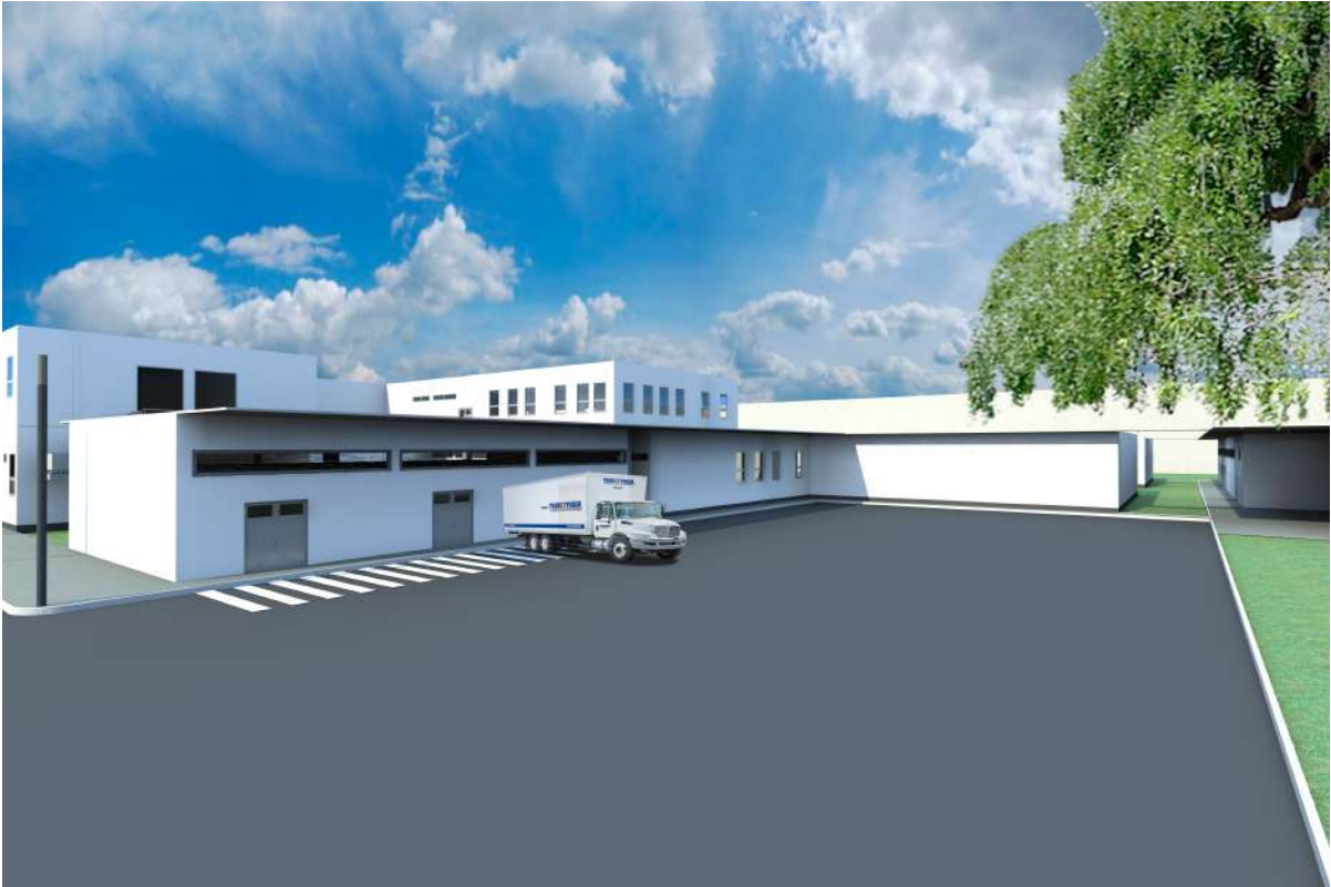
PATIO DE MANIOBRAS
