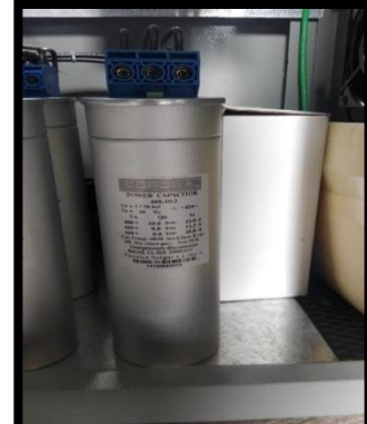
D. Banco de capacitores. D1. Placa de datos que se aprobó "propuesta de escenario uno" a instalar. -
