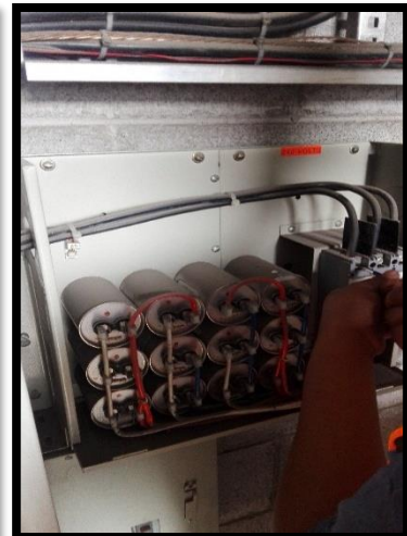
B. Banco de capacitores Arteche que se retiró por el banco de capacitores nuevo
