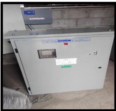
D. Banco de capacitores. D1. Placa de datos que se aprobó "propuesta de escenario uno" a instalar. -
