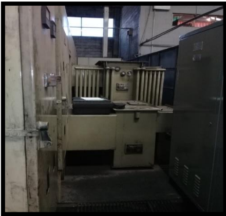
Transformador 750 kVA
