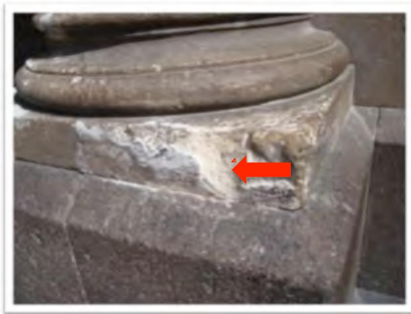
*Fig. 17 Pérdida de sección en columna de la fachada*
