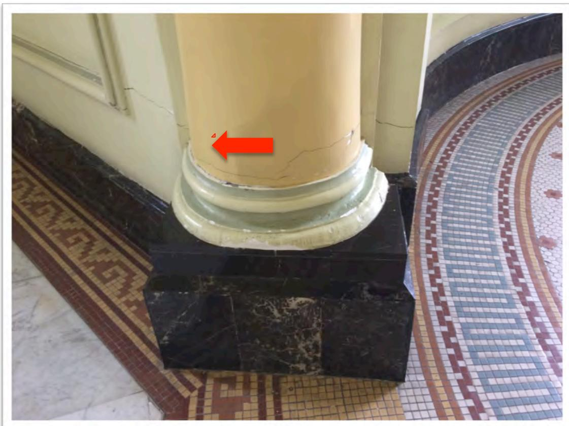
Fig. 10 Grietas en la parte baja de las columnas del vestíbulo principal.
