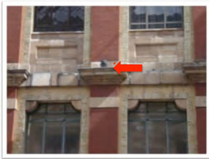
*Fig. 16 Esguimientos y erosión de cantera.*
