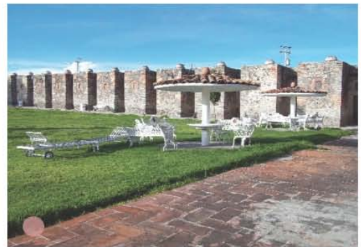
Orientación Noroeste; Habitaciones construidas con piedra.
