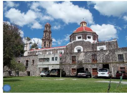
Vista de la catedral hecha de piedra, enmarcando su cúpula.
