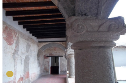
Corredor en planta alta, donde se aprecian las vigas de madera.
