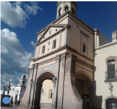
Acceso principal a la iglesia. La entrada al edificio es jerarquizada por la monumentalidad y los materiales tan pesados.
