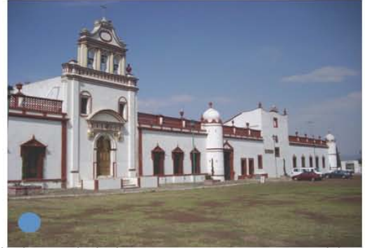
Fachada sur principal con arcos escarzanos y conopial.
