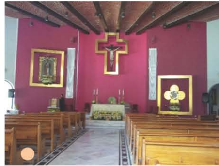
En la capilla se observa la bóveda de ladrillo acompañada por vigas de madera, que hacen del espacio un lugar fresco.
