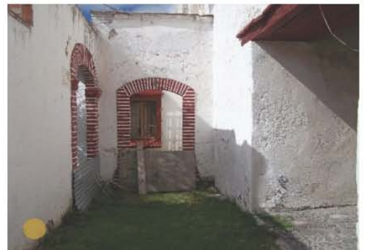
Utilización de arcos de medio punto.
