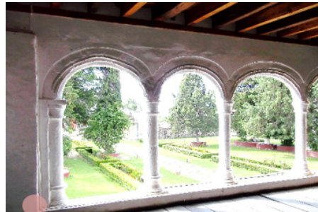
Los arcos de medio punto que forman parte de la fachada complemento del Ex convento Oxtotipac.
