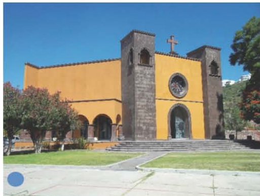
Fachada principal del templo, donde obtiene jerarquía gracias a su monumentalidad y a las columnas que enmarcan en acceso.
