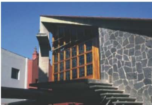
Escalera de concreto.
