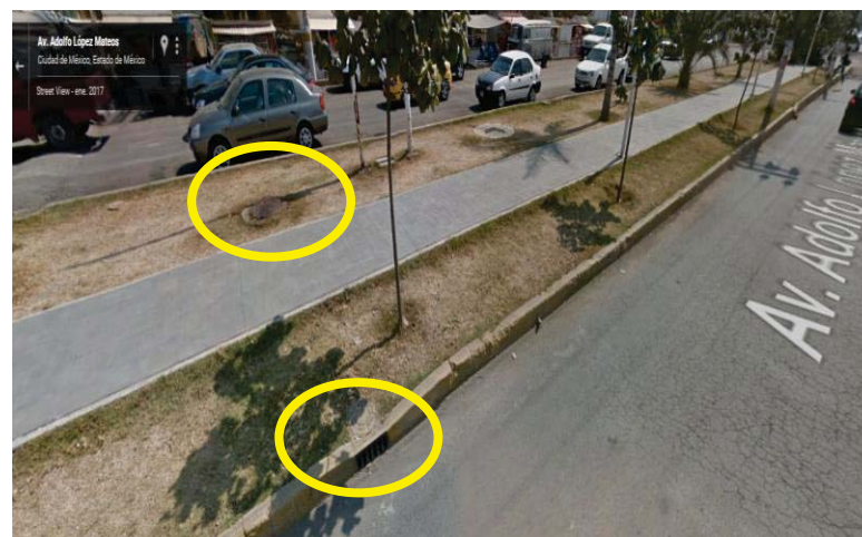
IMAGEN 25: Drenaje y Alcantarillado
