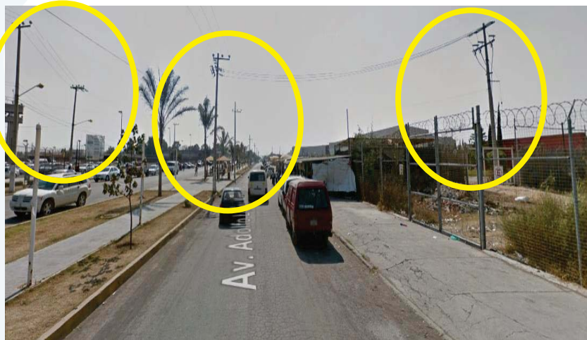
IMAGEN 25: Energía Eléctrica y Alumbrado Público
