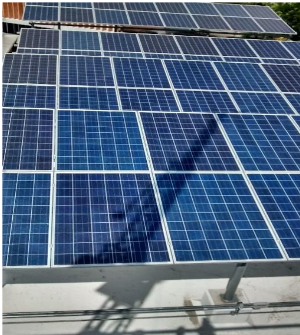
Figura III.24: Sombra en la cadena de módulos del lado Norte del edificio 3.1.
