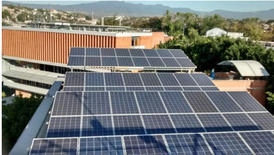
Figura III.27: Se puede ver que la cadena 1, 2 y 3 está sombreada mayormente por la mañana en el lado Norte del edificio 3.1.
