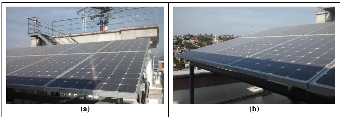
Figura IV.86: Primera cadena del SFV-IS con sombras que proyecta la CFV 2 sur.
