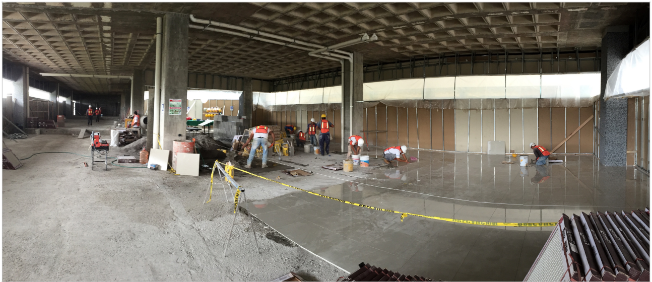
Figura 2.2 Interior del local. Colocación de piso porcelanato
