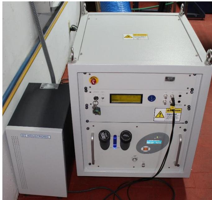
**Figura 17.** Transformador eléctrico (izquierda) y equipo controlador de la fuente láser (derecha).
