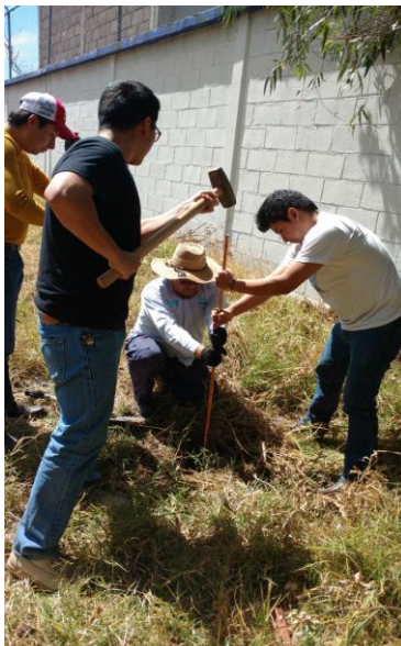
Figura 4.9 Varillas Copperweld siendo enterradas en el terreno para realizar el arreglo del sistema de puesta a tierra.
