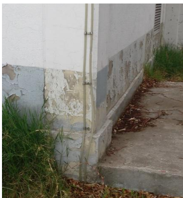
Figura 4.4a Conductor de puesta a tierra de estructuras metálicas y carcasas en azotea.
