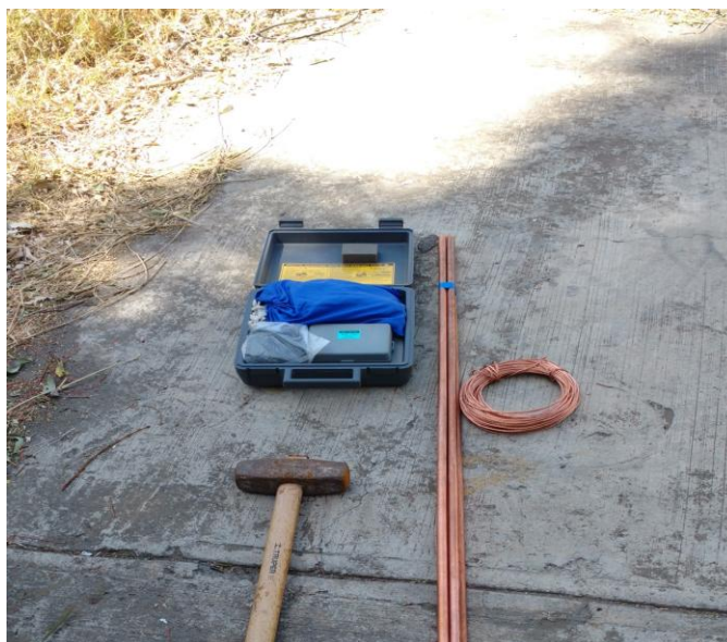
Figura 4.8 Material y equipo utilizado para la implementación del sistema de puesta a tierra propuesto.
