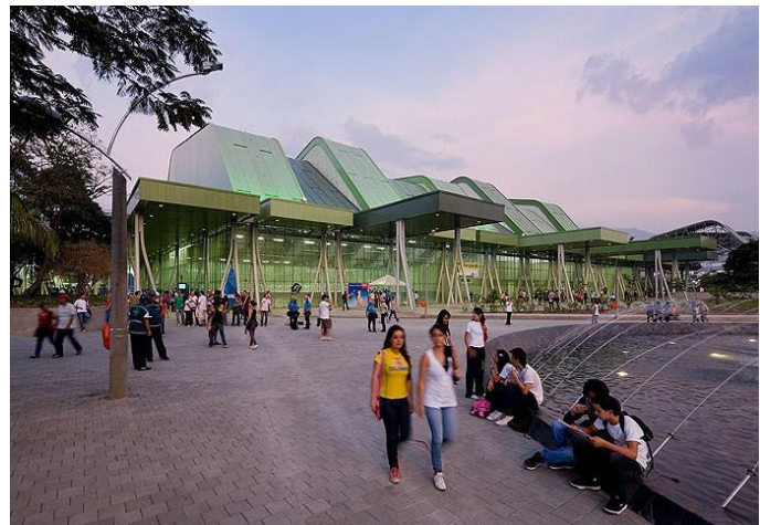
IMAGEN 19: Vista de la plaza pública a las instalaciones deportivas techadas Deportivos / Giancarlo Mazzanti + Plan B
