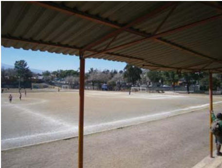
VISTA PONIENTE DEL TERRENO, EN EL CUAL SE PUEDE APRECIAR SU ESTADO ACTUAL
