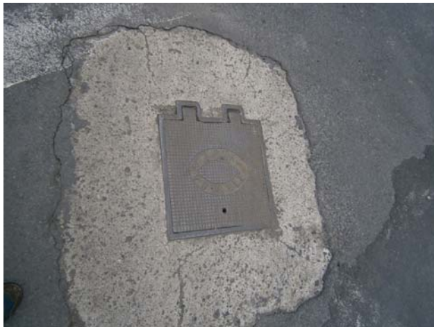
Agua Potable de la calle Campo
