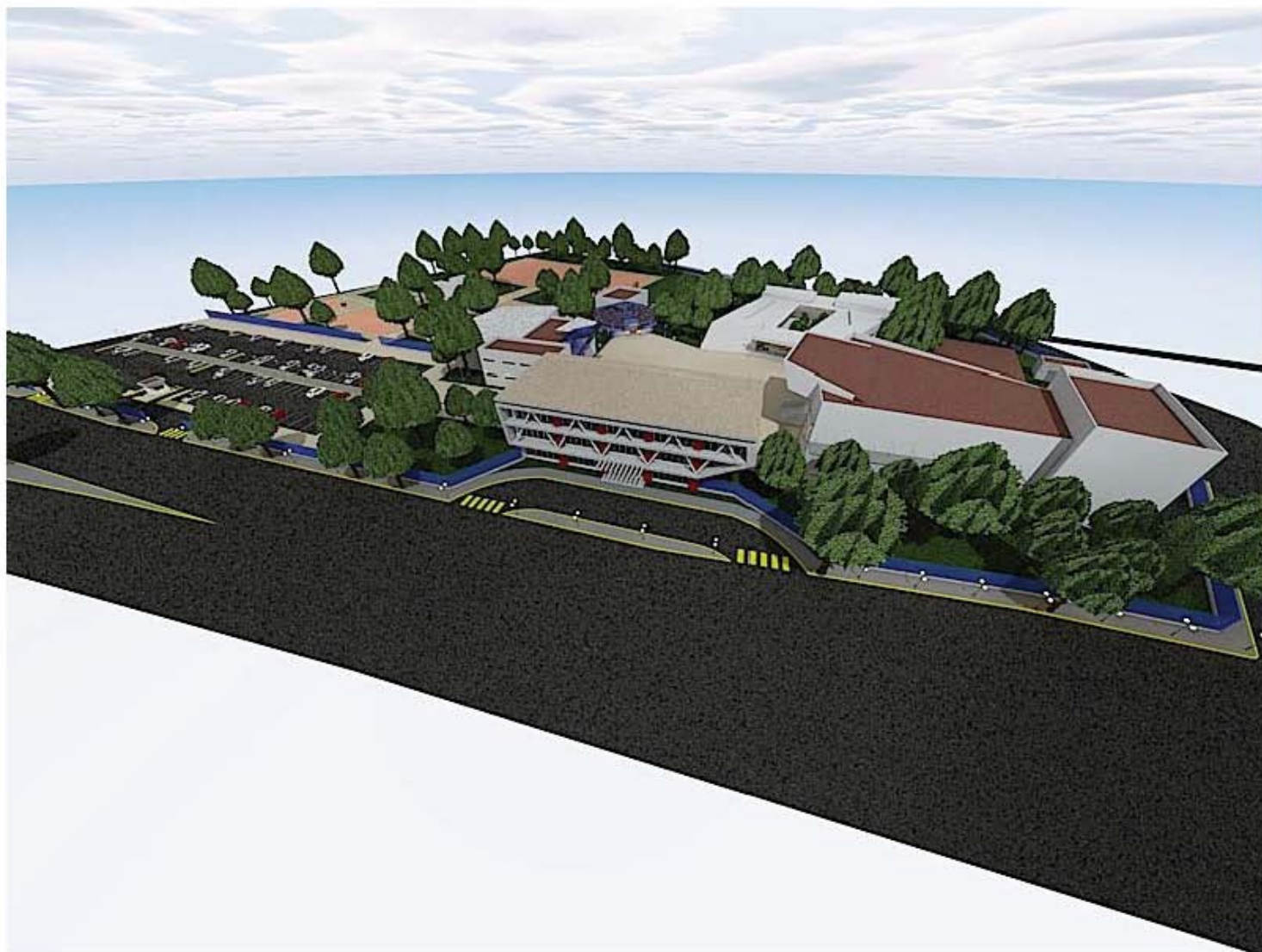
Vista del Conjunto desde Boulevard José López Portillo
