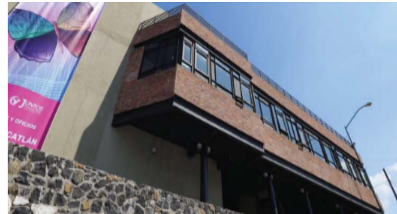
Casa de Cultura Faro Milpa Alta en San Antonio Tecómitl
