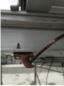
Figura III-6: Zapata de puesta a tierra
