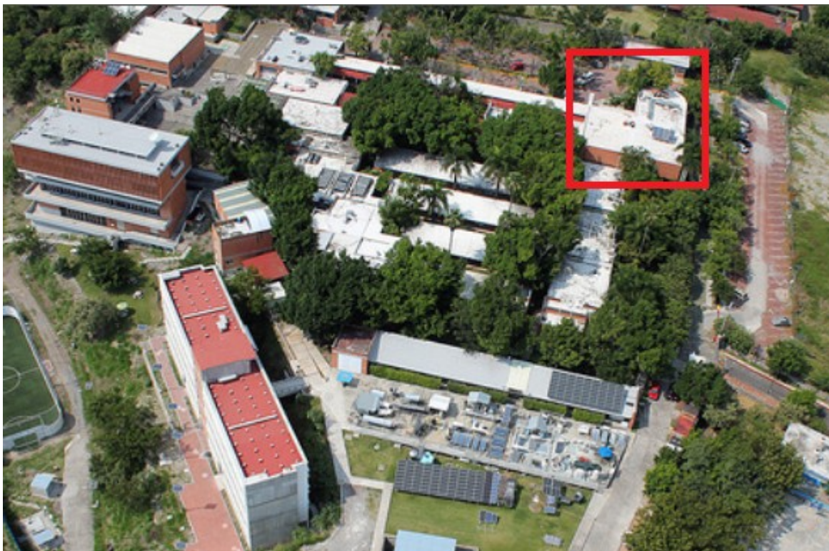
Figura IV-1: Imagen satelital de la techumbre del auditorio Tonatiuh
