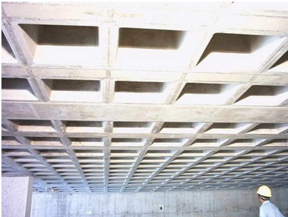
Imagen 37: Losa reticular perimetralmente apoyada Fuente: http://www.arkiplus.com/losa-reticular
