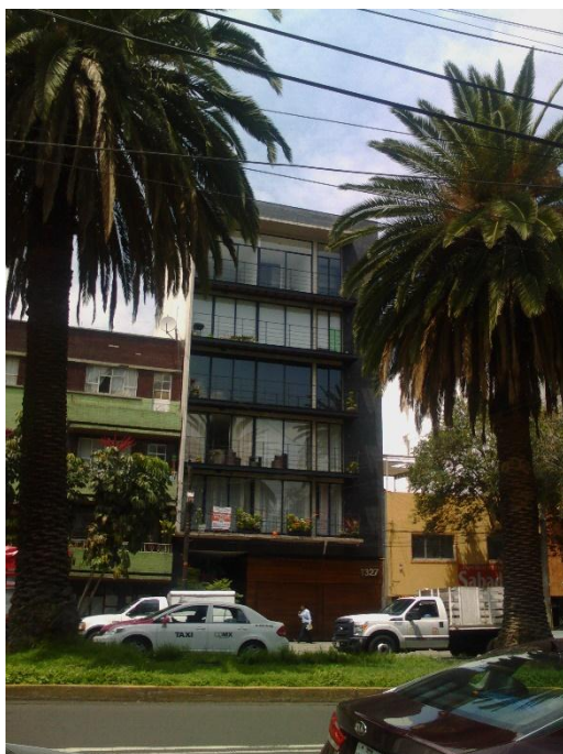
Imagen 29: Vista fachada de edificio habitacional Av. Vertiz Fuente: Adame Noriega (2016)
