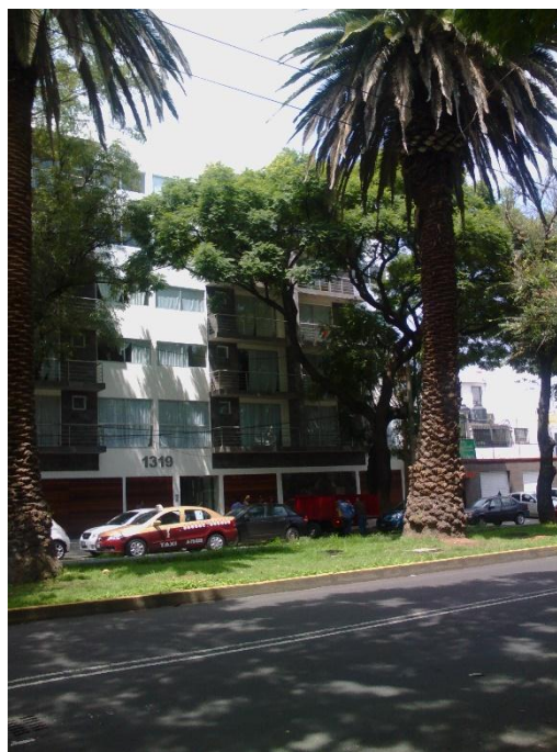
Imagen 30: Vista fachada de edificio habitacional Av. Vertiz Fuente: Adame Noriega (2016)
