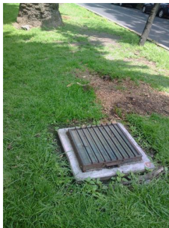
Imagen 14: Registro de red de agua Fuente: Adame Noriega (2016)
