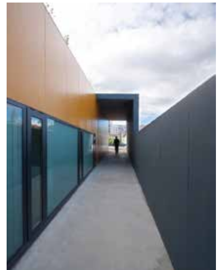
VISTA DE CIRCULACIONES
