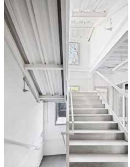
Vista de las circulaciones verticales
