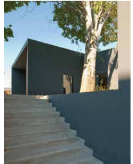
VISTA DEL ACCESO
