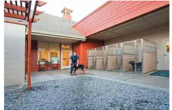
VISTA DE ASOLEADEROS Y PATIO
