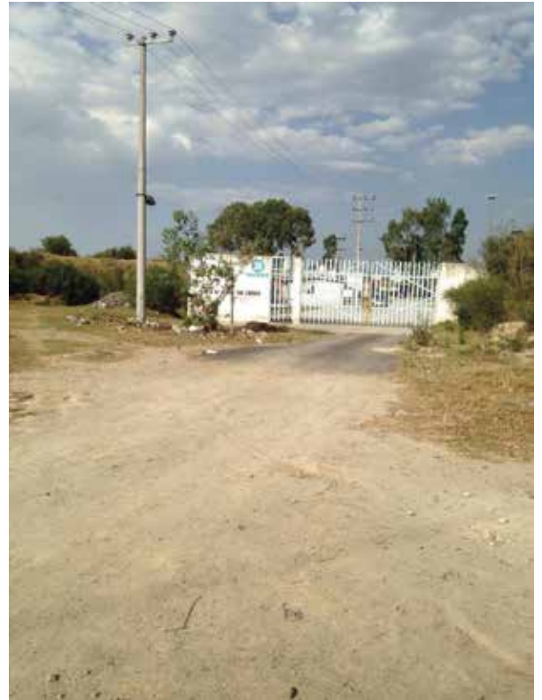
Planta de bombeo de San Lorenzo, colonia Miguel Hidalgo.
