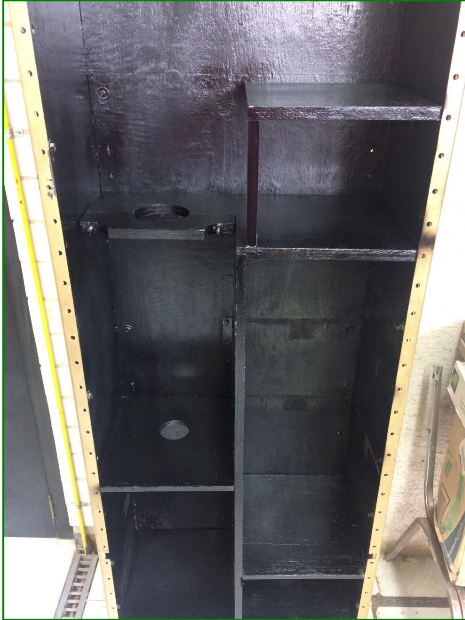
FOTOGRAFÍA 21 ESTRUCTURA DE MADERA (FUENTE: AUTOR)
