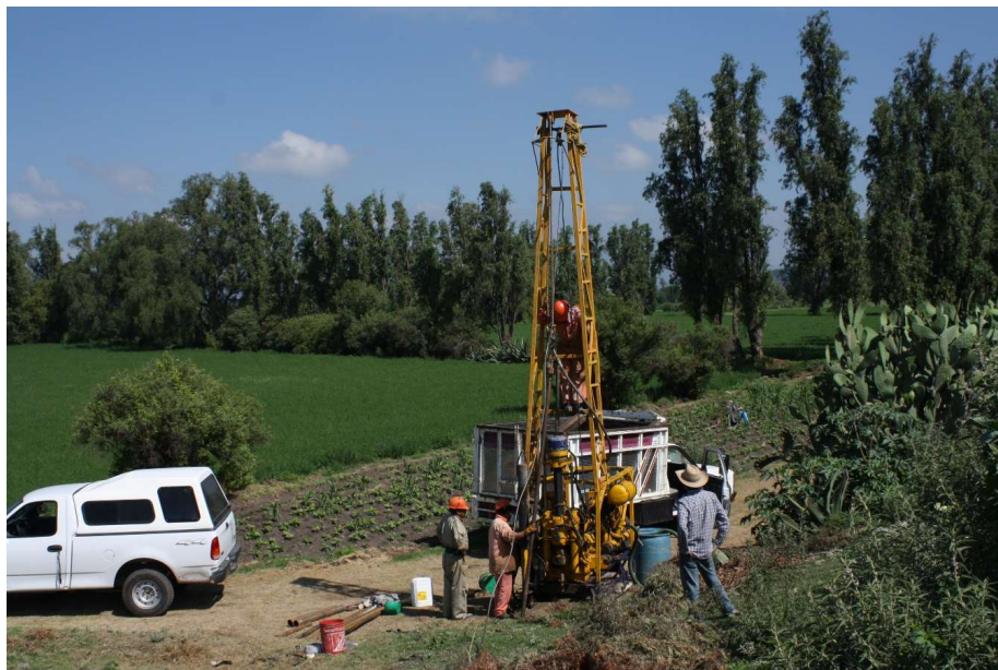
Figura 17. Equipo de perforación de pozos de observación.
