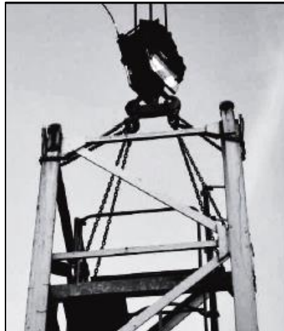
Figura 4.6.1.3. Sujeción correcta de elementos verticales.
