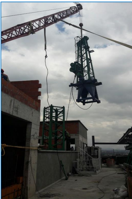
Figura 5.21. Desmontaje de la corona y elementos mecánicos. Fuente: Arq. Michel Tomé Toriz.
