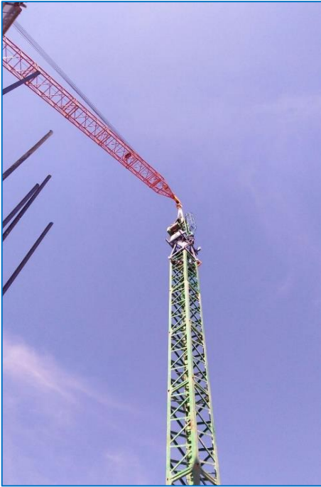
Figura 5.7. Montaje de la corona y elementos mecánicos. Fuente: Arq. Michel Tomé Toriz.
