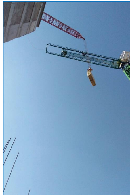
Figura 5.10. Puesta de los contrapesos de montaje. Fuente: Arq. Michel Tomé Toriz.
