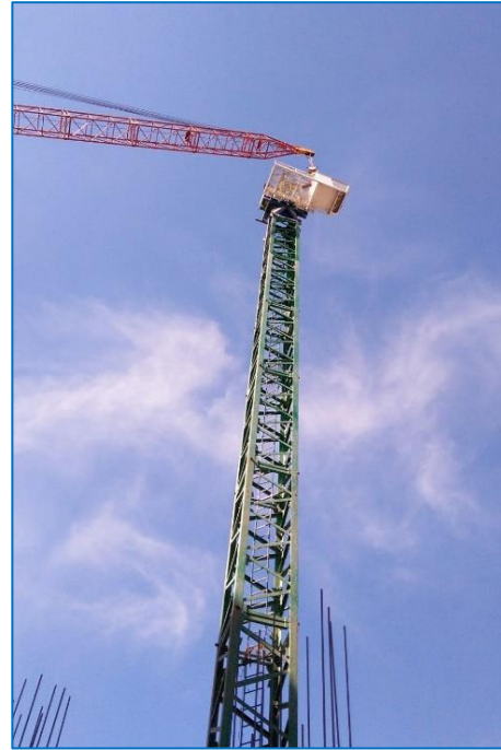
Figura 5.8. Instalación de la caseta de operación. Fuente: Arq. Michel Tomé Toriz.
