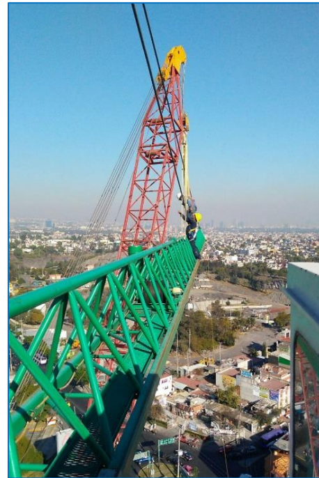
Figura 5.12. Instalación de los tirantes de la pluma. Fuente: Arq. Michel Tomé Toriz.
