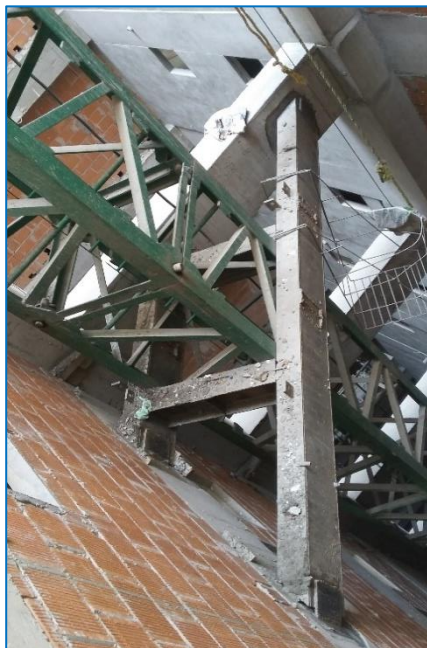
Figura 5.5. Estructura de estabilización de la torre. Fuente: Arq. Michel Tomé Toriz.
