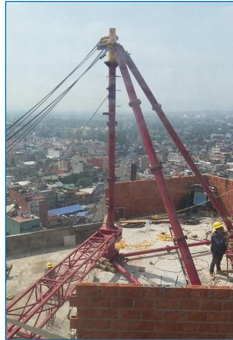
Figura 5.16. Montaje de la grúa Derrick. Fuente: Arq. Michel Tomé Toriz.
