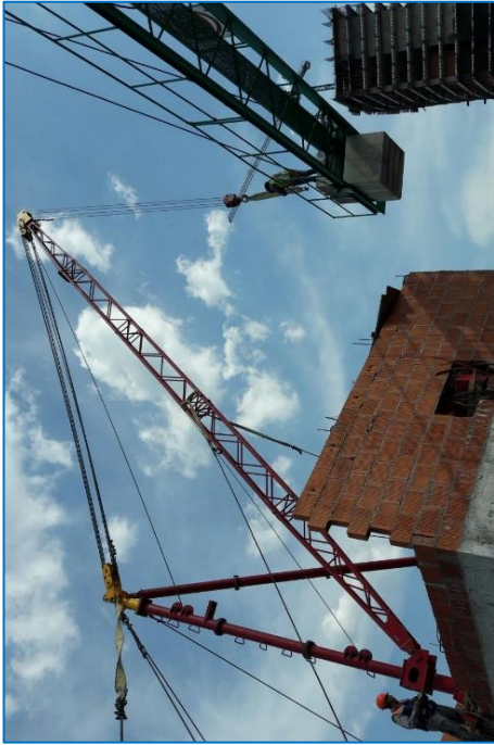
Figura 5.19. Retiro de contrapesos de montaje. Fuente: Arq. Michel Tomé Toriz.
