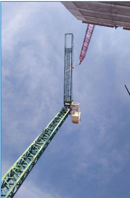
Figura 5.9. Montaje de la contrapluma. Fuente: Arq. Michel Tomé Toriz.
